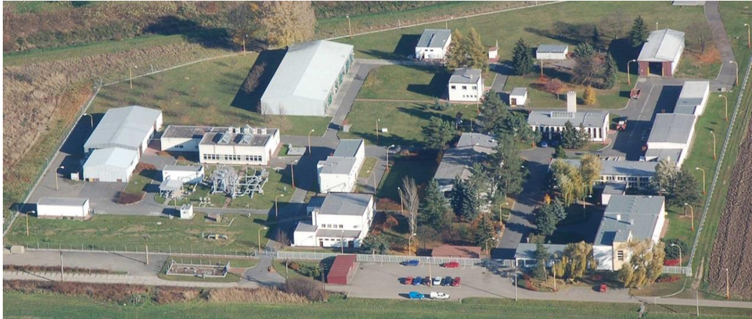
Obr. 15: Zásobník plynu Lobodice (Zdroj: https://www.rwe-gasstorage.cz , 2021)
