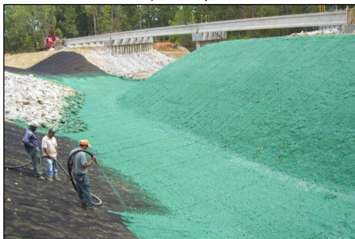
Obr. 4: Aplikace hydroosevu
