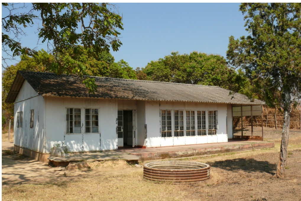
Obr. 2 Hlavní budova NGO New Renato
