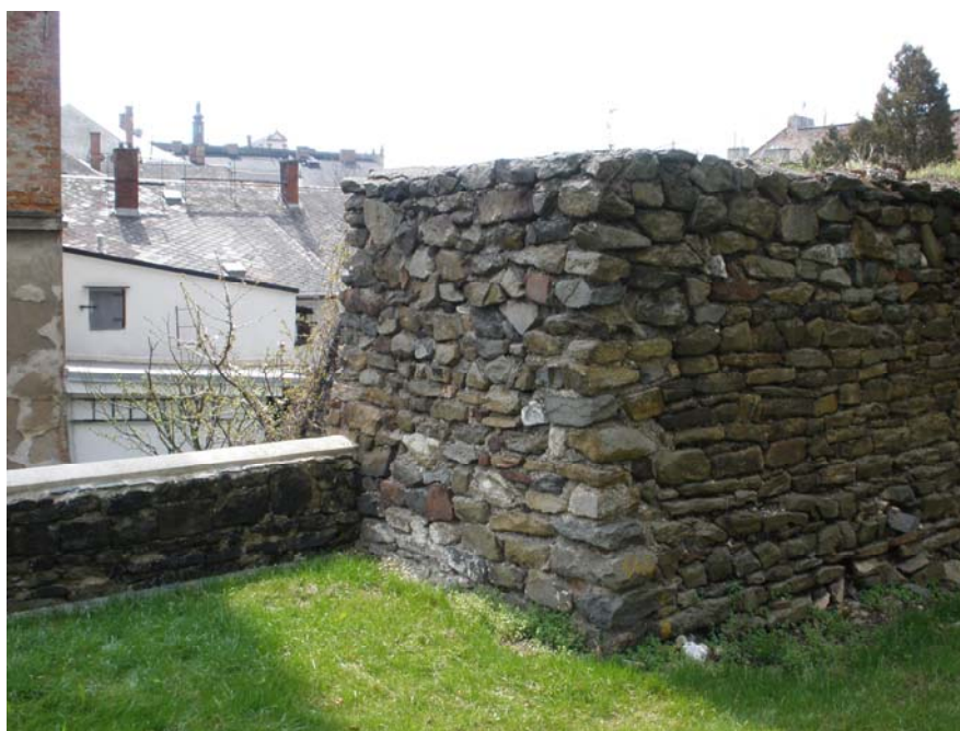
Obr. 19: Napojení parapetní zídky na zbytek románské hradby
