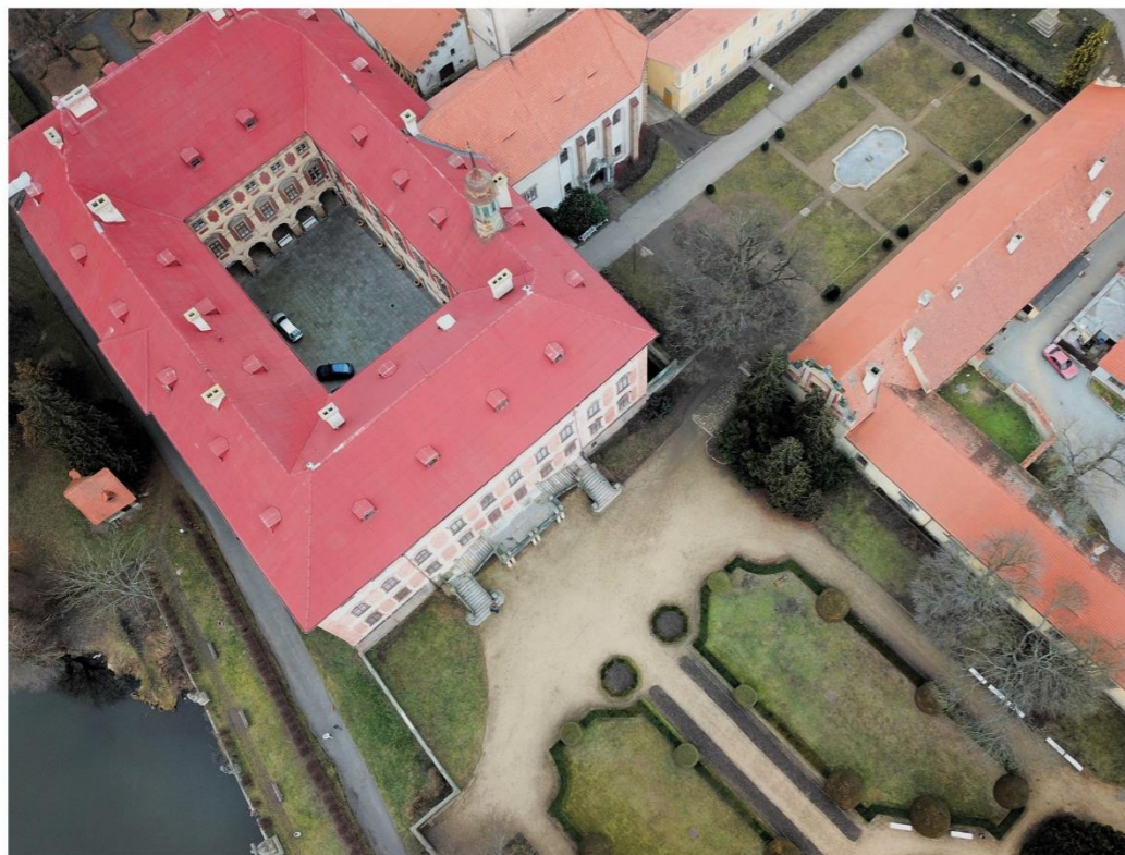
Obr. 68 Nadhledový snímek zachycující obdélný čtyřkřídlý zámek s uzavřeným vnitřním nádvořím s arkádami. Fasáda zámku je zdobena raně barokními frontony a dělením v původní barevnosti. (Zdroj: Vlastní snímek)
