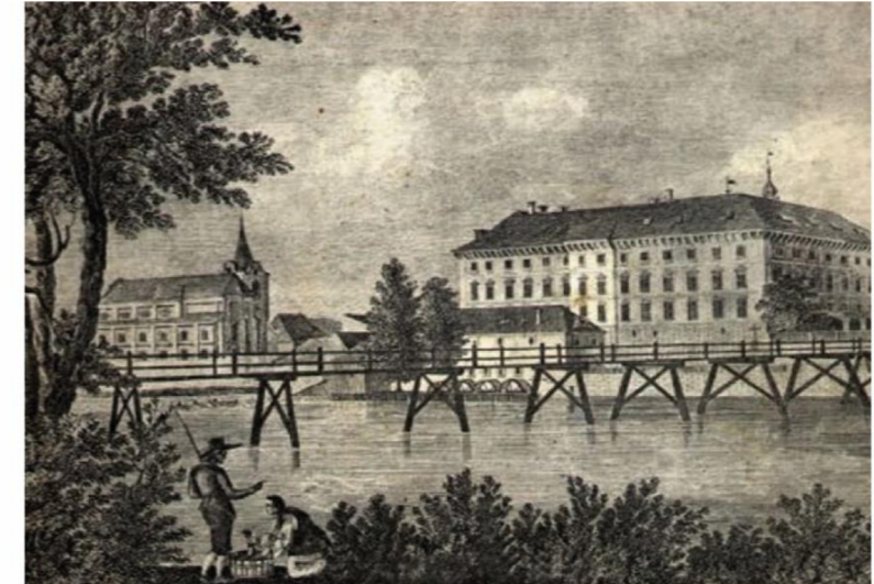
Obr. 21 Pohled na zámek s dřevěným mostem, litografie z roku 1850. Historický snímek zachycuje též dřevěný most na dřevěných pilotách, který byl vždy při tání ledu rozebírán a sloužil mnoho let s několika obnovami až do jeho nahrazení mostem ocelovým. (Zdroj: https://libochovice.blogspot.com/ )
