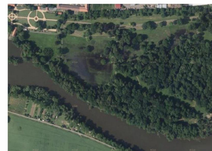
Obr. 13 Orthofotomapa z roku 2013 , stav po povodních. kdy došlo k vylití koryta a zaplavení přírodně krajinářské části parku. V důsledku povodni došlo k poškození abiotických (cestní síť) i vegetačních prvků v parku. Přistoupeno bylo ke stabilizačním opatřením, kácení a novým výsadbám. ( https://cuzk.cz )
