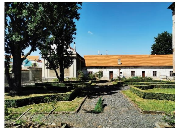
Obr. 44 - 45 Úprava vegetace v bezprostřední blízkosti zámku je pravidelná a čistě formální. Na severním parteru (čestný dvůr) převažuje travnatá plocha, která pokrývá většinu jeho vegetačního krytu. Dalšími vegetačními prvky jsou stříhané tisy a růžové záhony, které by zasloužily obměně. Jednoduchému parteru dominuje vzrostlá lípa ( Tilia cordata ). Nedořešené a neuspořádaně působí i stinný záhon pod lípou a keřová skupina při zdi pozdně gotické kaple.
