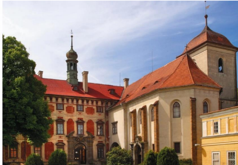
Obr. 30 Nejvýznamnější stavbou parku je samotná budova raně barokního zámku a přilehlé zámecké kaple, které spolu tvoří úchvatný prostor severního parteru. (Zdroj: https://npu.cz )
