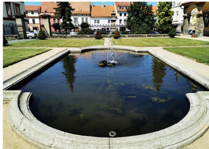
Obr. 34 Fotografie obdélného bazénu ze 17. stol. v centrální části čestného dvora s dlážděným kamenným dnem vymezený kamennými deskami s převýšenou profilovanou hranou a květinovou plastikou vodotrysku. (Zdroj: vlastní fotografie )
