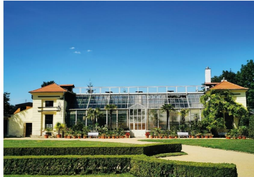
Obr. 31 Sbírkový palmový a zásobní skleník s litinovou konstrukcí a sedlovou střechou. Skleníky se nacházející při zadním cípu hlavního parteru a čekají na nutnou rekonstrukci. (Zdroj: vlastní fotografie )
