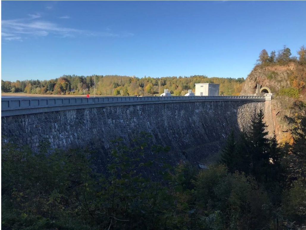
Foto 5 Přehrada vodní nádrže Seč
