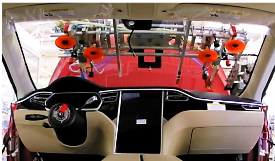
Obr. 16 Montáž čelního skla automobilu Tesla S, pohled zevnitř [32].
