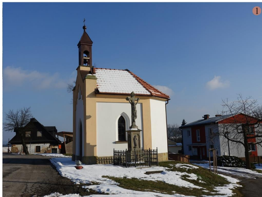
Obr. č. 56: NÁVES V DOBRÉ VODĚ má ve svém centru umístěnou kapli se dvěma mladými lípami. Kolem kaple se nachází autobusová zastávka, obecní úřad (budova vpravo), jeden starý dochovaný statek a další budovy rodinné zástavby.
