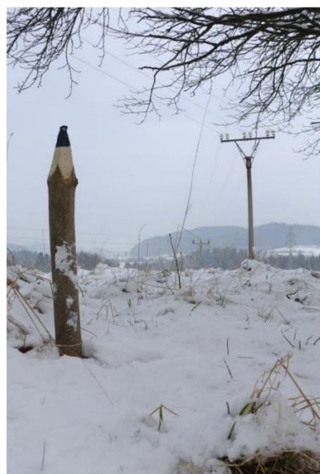
Obr. č. 93: Vedení VN
