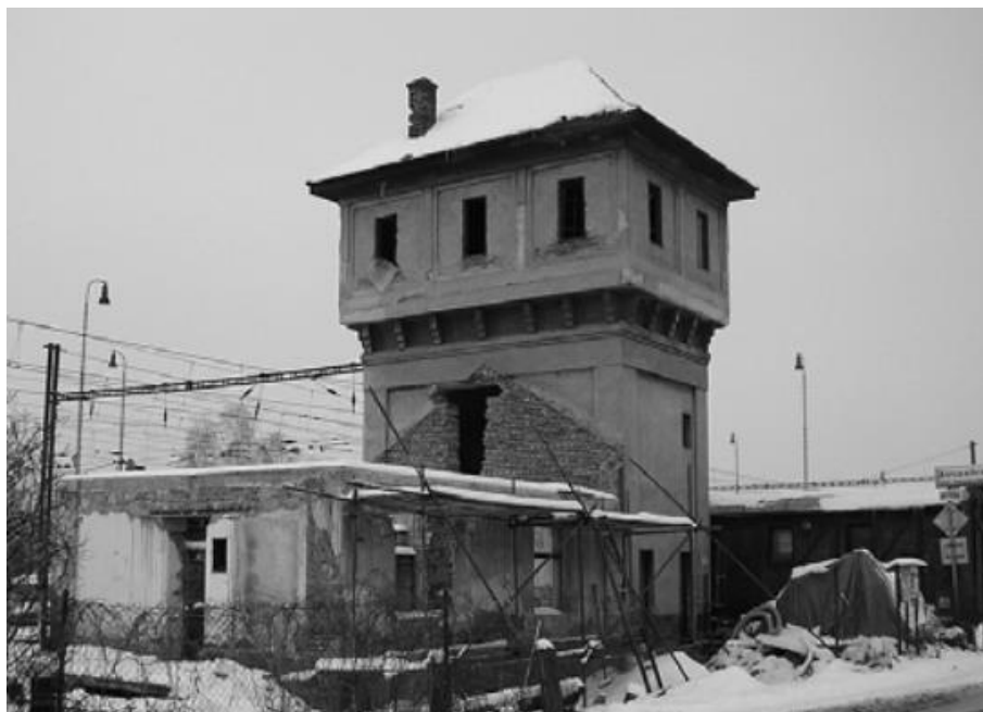
Obrázek F7: Vodárenská věž „U Sekalů“ před rekonstrukcí v roce 2009
