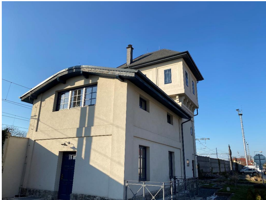
Obrázek F8: Vodárenská věž „U Sekalů“ po rekonstrukci v roce 2020
