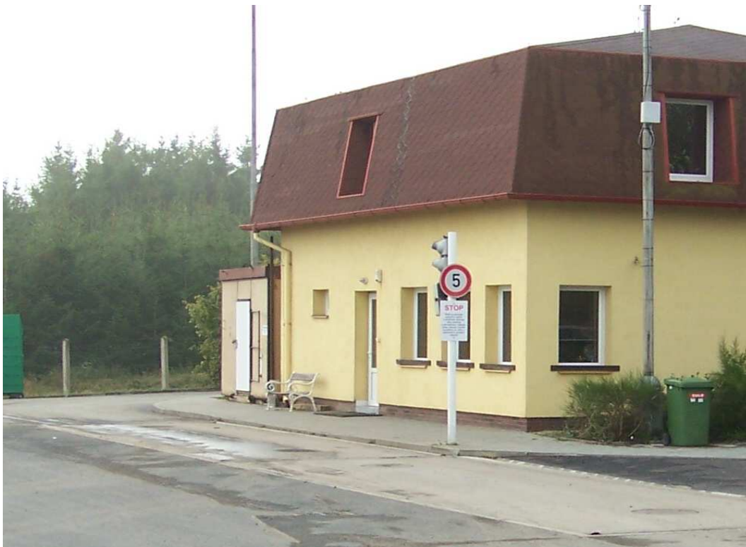
Obr.22: Váha a administrativní budova
