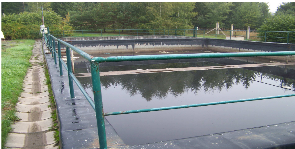
Obr.14: Jímka průsakových vod
