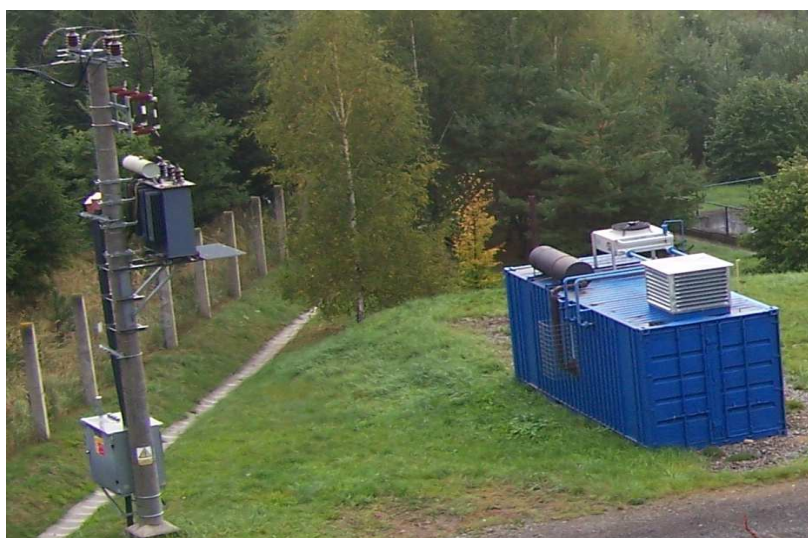
Obr.15: Kogenerační jednotka
