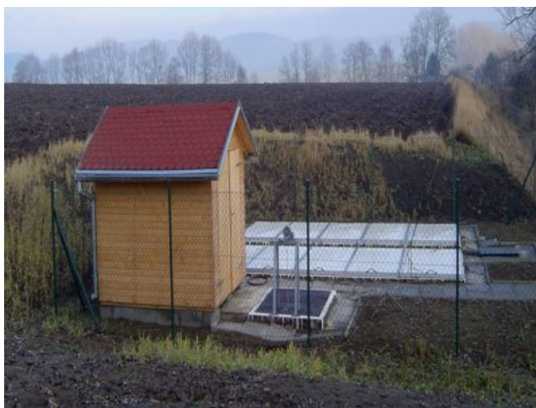
Obr. 5.6 Balená čistírna 2x100 EO [21]
