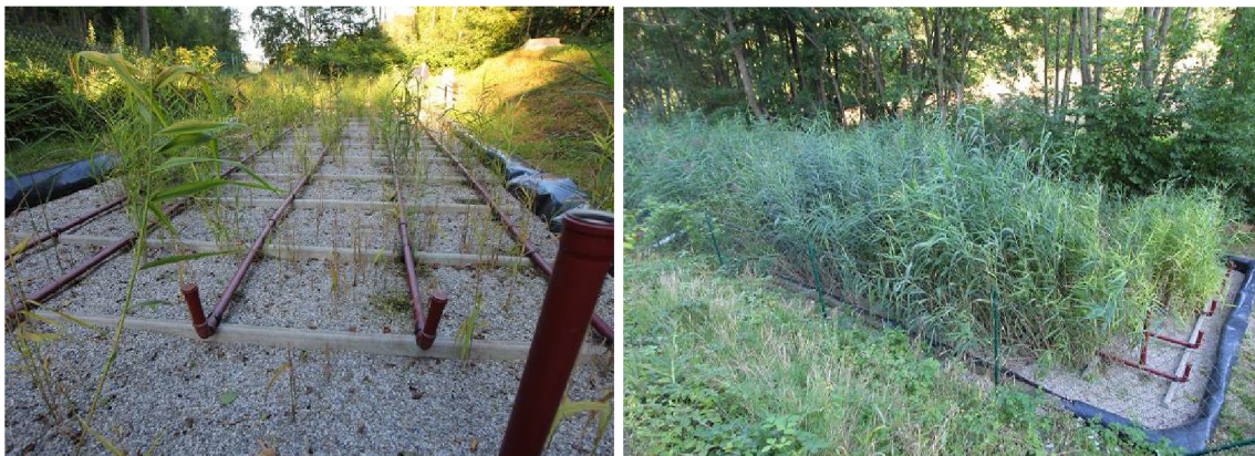
Obr. 5.11 Vertikální filtr [33]
