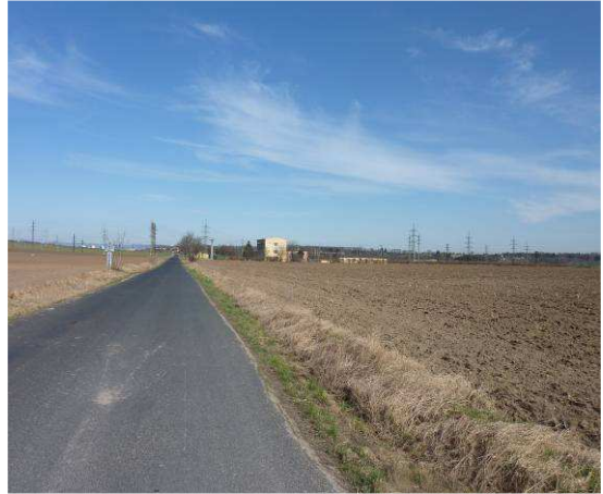
Obr. č. 166 Rozvodna elektrické energie a za obcí Kleneč (autor)
