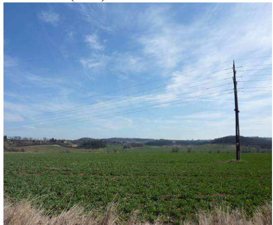
Obr. č. 168 Rozvodna elektrické energie a za obcí Kleneč (autor)
