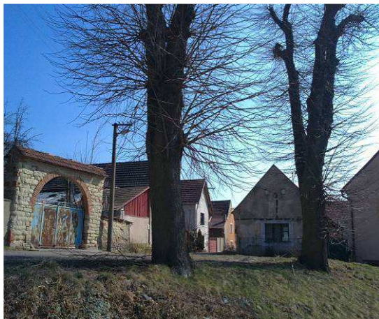
Obr. č. 231 Dochovaný charakter a forma staveb v obci Libkovice p.Ř. - zděná brána se „sluncovými vraty“ (autor)
