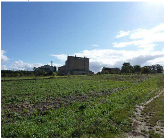
Obr. č. 131 Objekt sušičky hmotově dominující intravilánu obce Černouček (autor)
