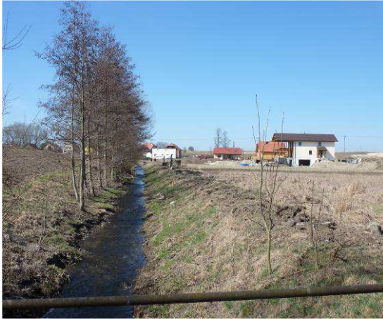
Obr. č. 165 Upravené koryto potoka Čepel v obci Kleneč (autor)
