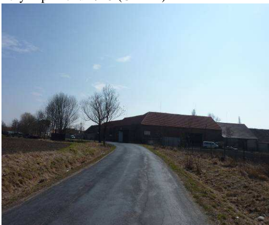
Obr. č. 137 Dominantním prvkem Mnetěše jsou statky tvořící obvod návsi (autor)
