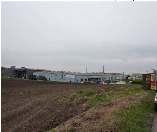
Obr. č. 197 Výrobní areál fy. Johnson Controls v Roudnici n.L. (autor)
