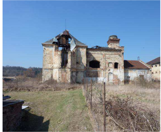
Obr. č. 220 Současný stav areálu bývalého pivovaru v H. Beřkovicích (autor)
