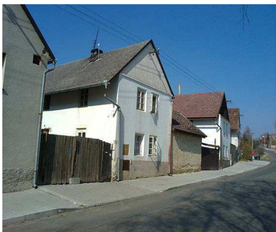
Obr. č. 232 Dochovaná forma a architektonický vzhled staveb v obci Libkovice p.Ř. (autor)
