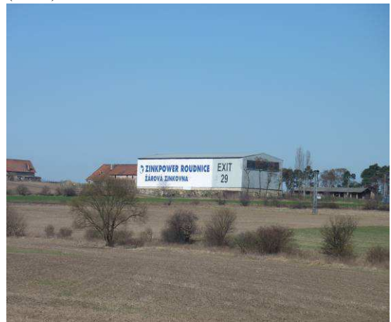
Obr. č. 174 Hmotově výrazná stavba haly v západní části Klenče (autor)
