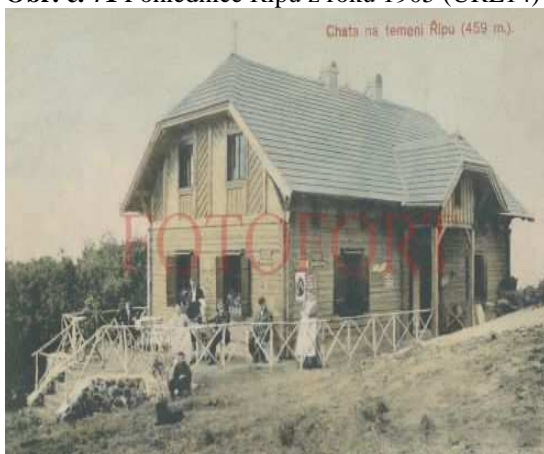
Obr. č. 73 Pohlednice z roku 1909 – chata na temeni Řípu (URL14)
