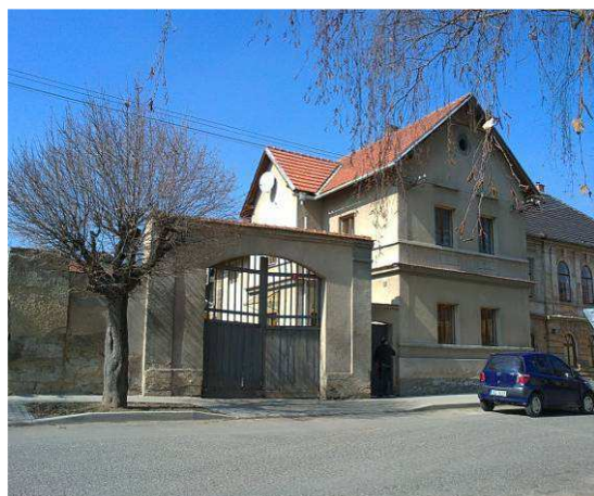
Obr. č. 227 Dochovaný charakter a forma historických staveb v obci Libkovicích p.Ř. (autor)
