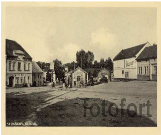
Obr. č. 155 Charakter a struktura zástavby v obci Straškov rok 1929 (URL14)
