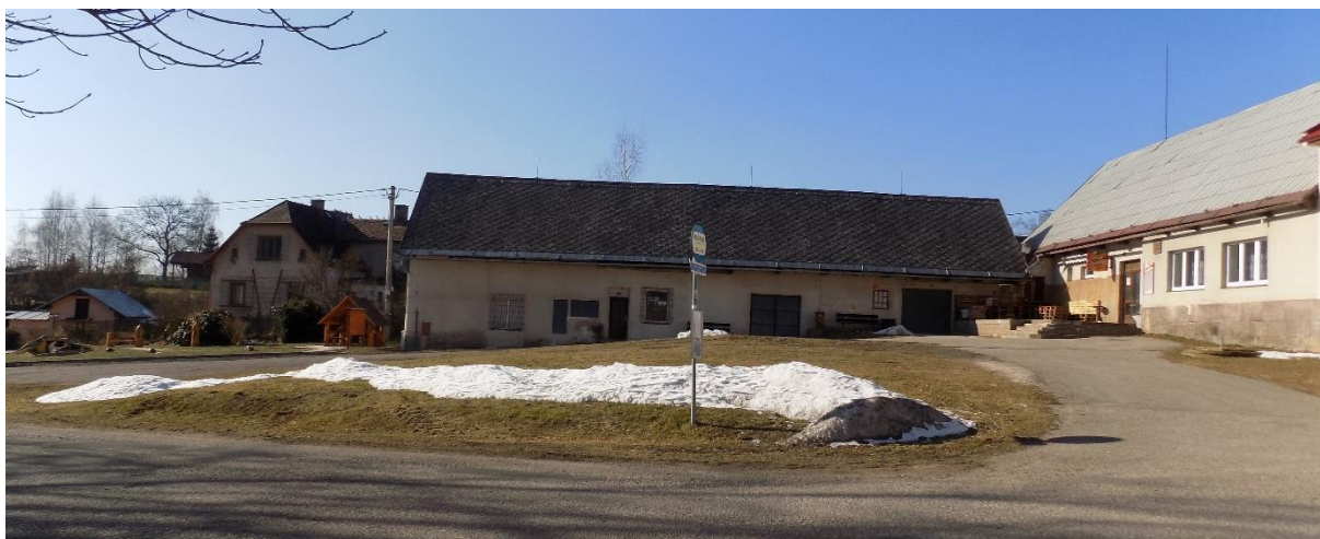
Obrázek č. 23 Plocha před č. p. 92 - stav v únoru 2018.
