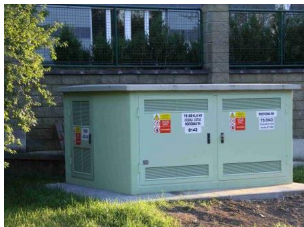
Obrázek č. 21 Kioskové trafostanice typově vhodnější pro zastavěné území obce.
