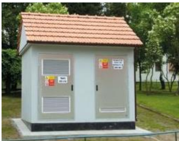
Obrázek č. 21 Kioskové trafostanice typově vhodnější pro zastavěné území obce.
