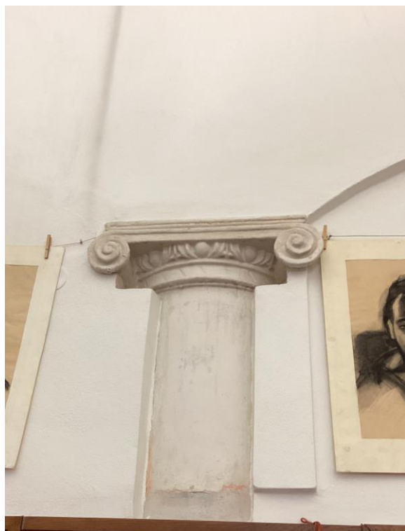
32. Prostějov, zámek, částečně zazděný sloup v přízemí východního křídla.
