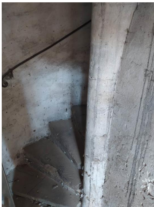
45. Prostějov, zámek, točité schodiště v síle zdi východního křídla.
