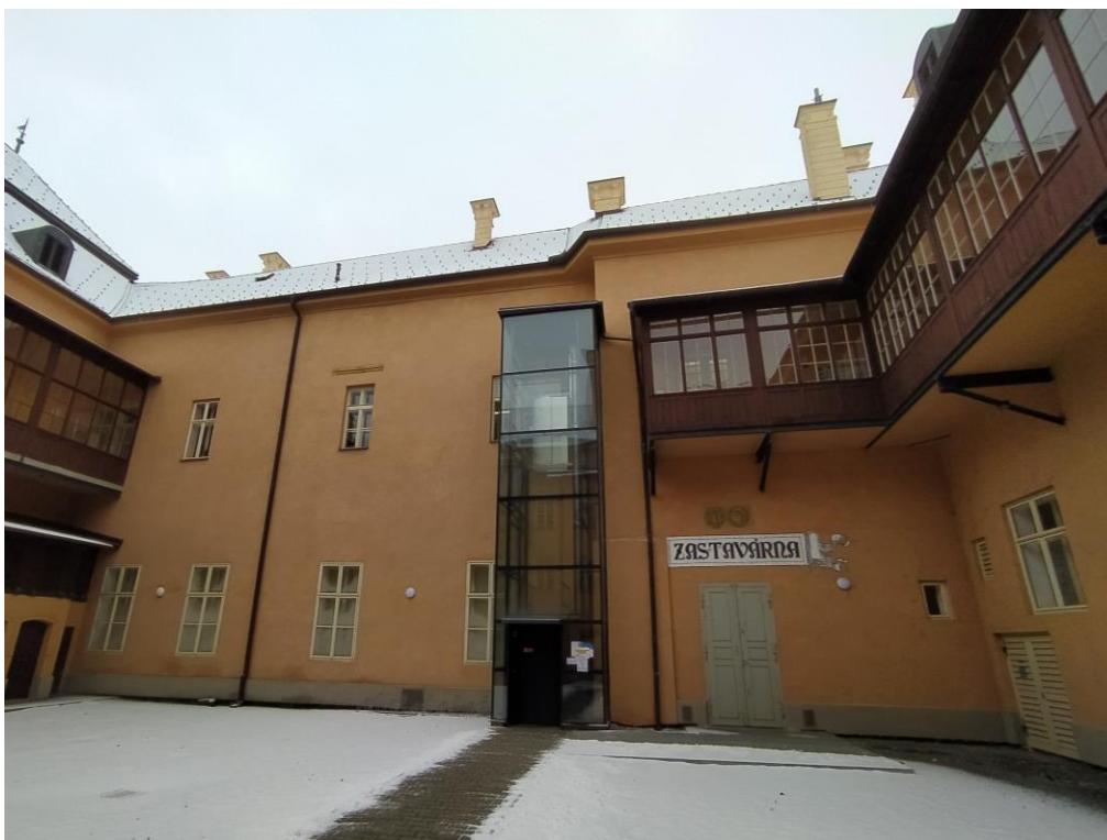
23. Prostějov, zámek, nádvoří, severní průčelí.
