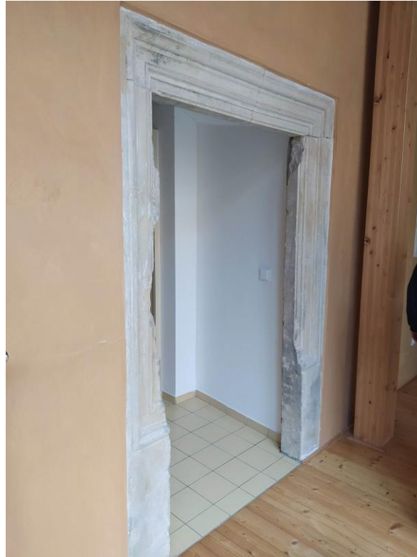
33. Prostějov, zámek, portál v mezipatře jižního křídla.
