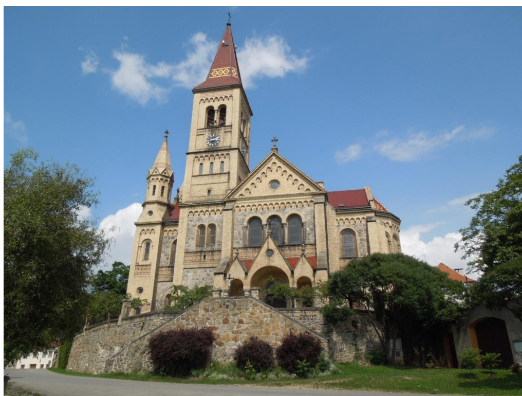
Obr. č. 6. Hosín – farní kostel svatého Petra a Pavla (exteriér)
