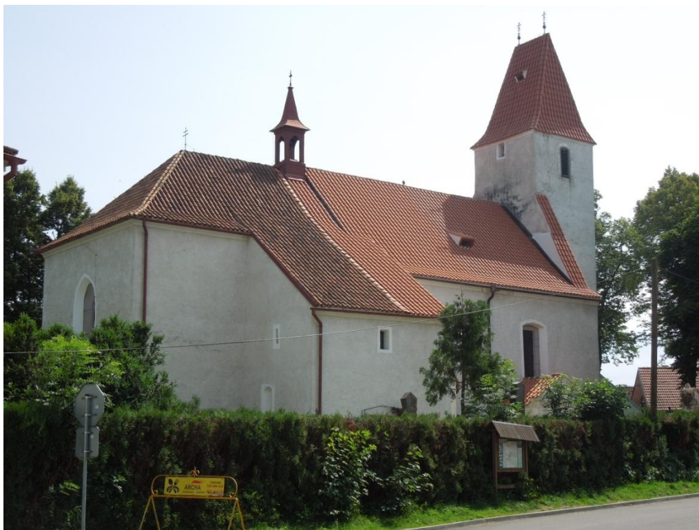
Obr. č. 1. Boršov – farní kostel svatého Jakuba Většího (exteriér)
