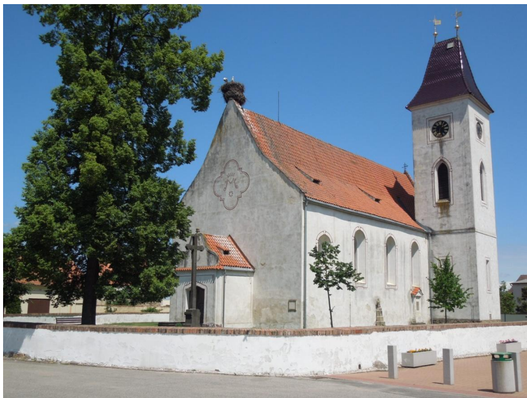
Obr. č. 5. Dubné – farní kostel Nanebevzetí Panny Marie (exteriér)
