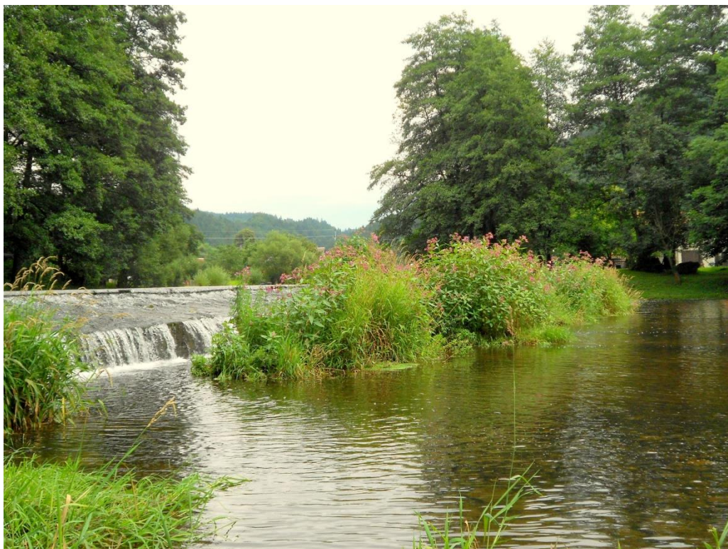
Obrázek 3 Pohled na jez na Svratce ve Švařci
