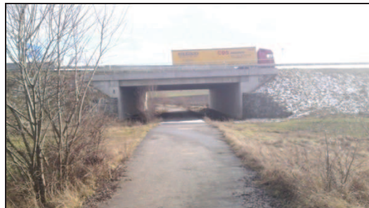
Foto 2: Podchod pod D5
