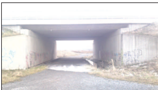
Foto 1: Podchod č. 1 pod silnicí I/27
