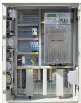
Obr. 6-1 Řadič MR – 11 a příklad použití [12]
