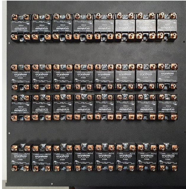
Obrázok 6.3 Rozloženie relé pevných stavov
