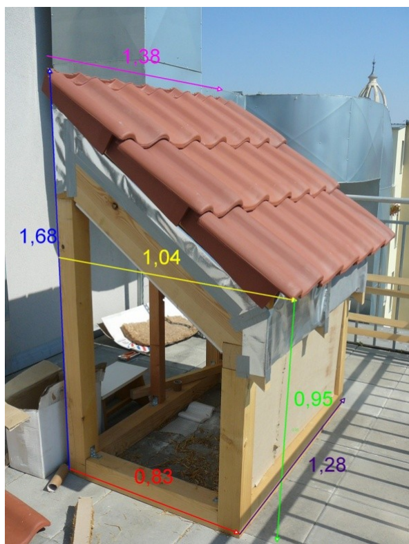
Obr. 7 Model střešního pláště
