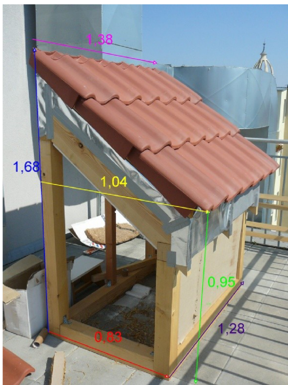
Obr. 7 Model střešního pláště
