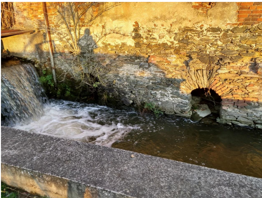
Přil. č. 37: Ve zdi objektu jasně patrné dva vstupy pro hřidele (Šumvald, 2019)
