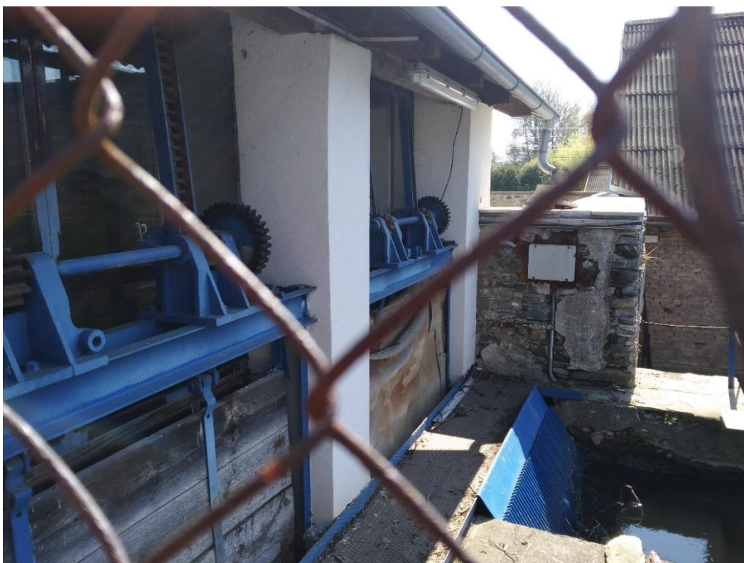
Foto. č. 16: Stavidlová stěna strojovny postavená s největší pravděpodobností na původních základech mlýna (Nová Hradečná, 2019)
