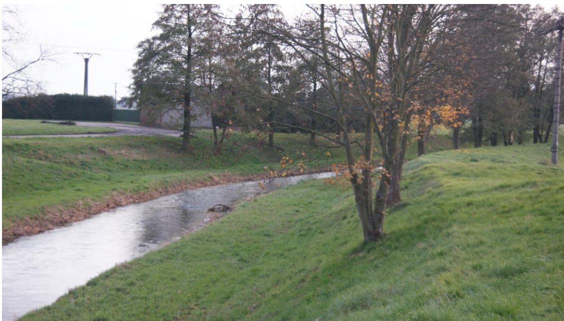
Foto. č. 1: Upravené koryto řeky Oskavy za Brníčským mostem, 2018 (Uničov, 2018)
