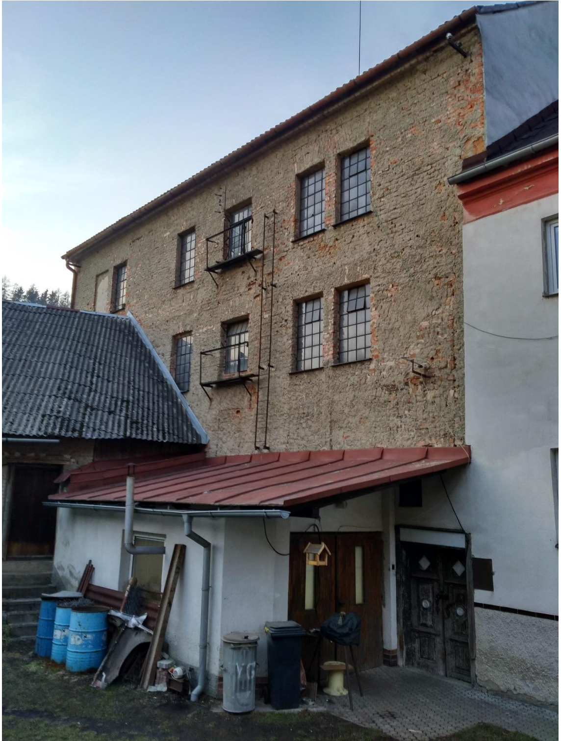
Foto. č. 12: Pohled na objekt ze dvora č.p. 196 (Oskava, 2019)
