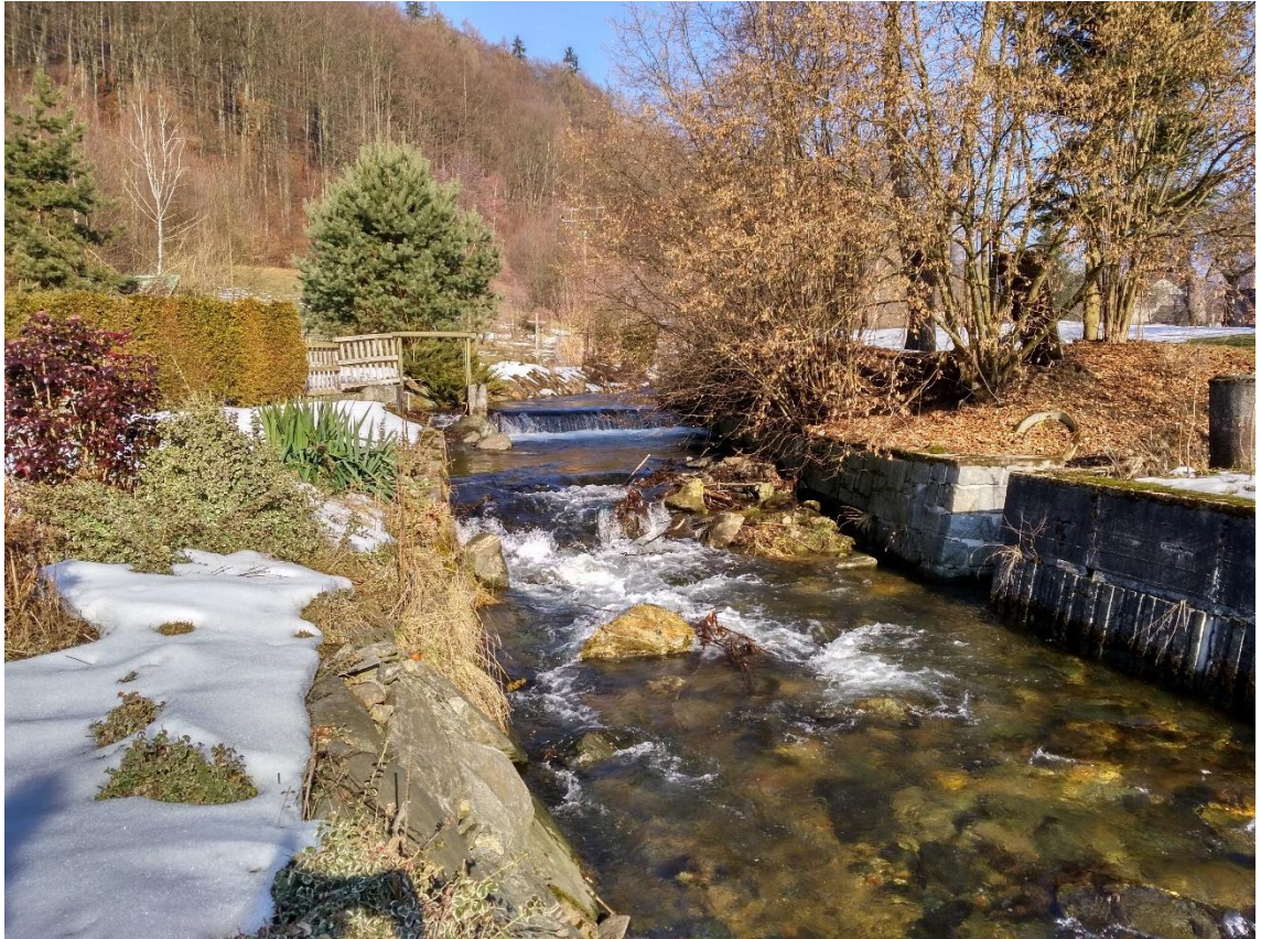
Foto. č. 5: Jasně patrný jez ke zdvižení vodní hladiny ke koželužně (Oskava, 2019)
