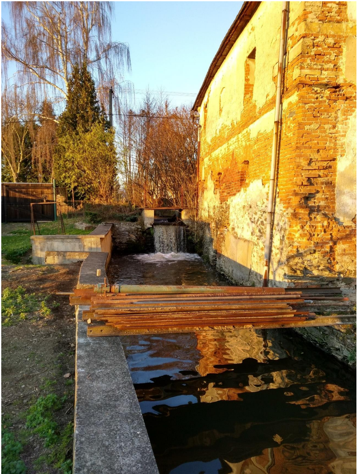
Příl. č. 39: Přepad vody, kudy pravděpodobně původně vedly vantroky pro hnání vody na dvě vodní kola (Šumvald, 2019)
