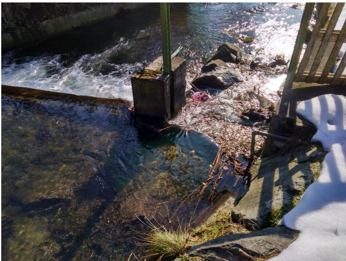
Příl. č. 18: Předpokládaná vpusť vodního náhonu k č.p. 12 (Oskava, 2019)
