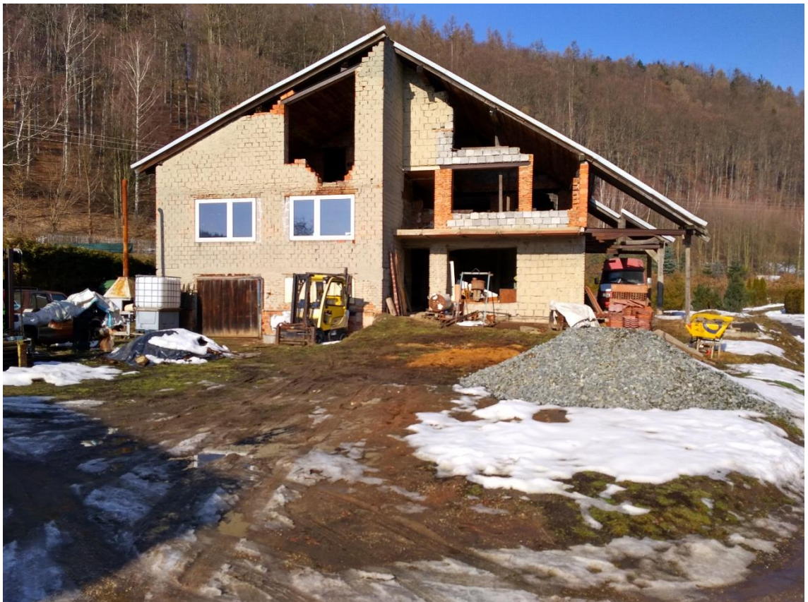
Foto. č. 6: Dům na lokalitě koželužny č.p. 12 (Oskava, 2019)
