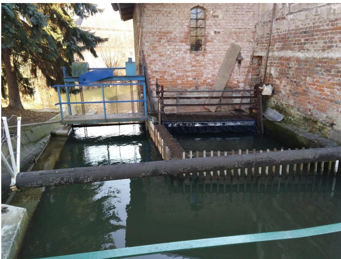
Příl. č. 91: Pohled z mostu na přepad, stavidlo a česle u MVE v Liboši (Štěpánov-Liboš, 2019)
