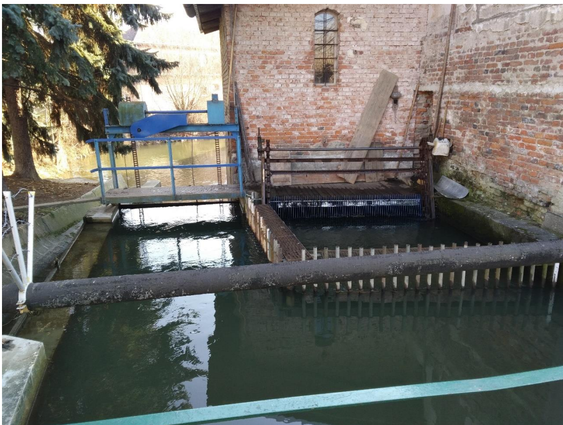
Příl. č. 58: Pohled z mostu na přepad, stavidlo a česle u MVE v Liboši (Štěpánov-Liboš, 2019)
