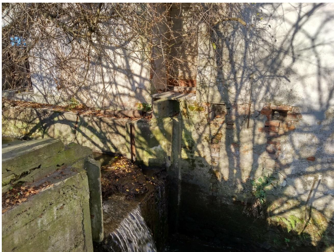
Foto. č. 19: Přepad náhonu (větší část vody teče vnitřním potrubím v části pod přepadem, místo je těžko přístupné), ve zdi pak patrná konstrukce pro stavidlo. Zářezy v betonu nasvědčují vantroakům, potvrdit se však nepovedlo (Uničov, 2019)
