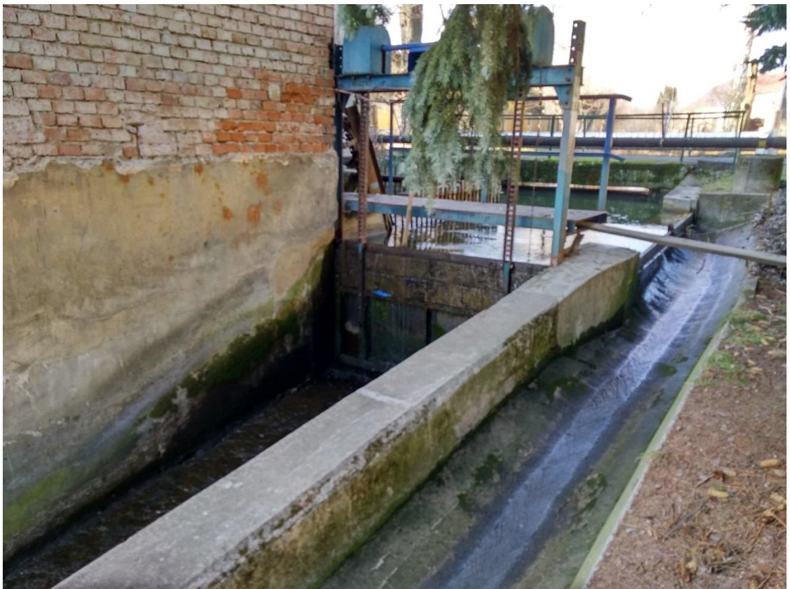
Foto. č. 24: Stavidlo náhonu pro upouštění a bezpečnostní přepad u MVE (Štěpánov-Liboš, 2019)
