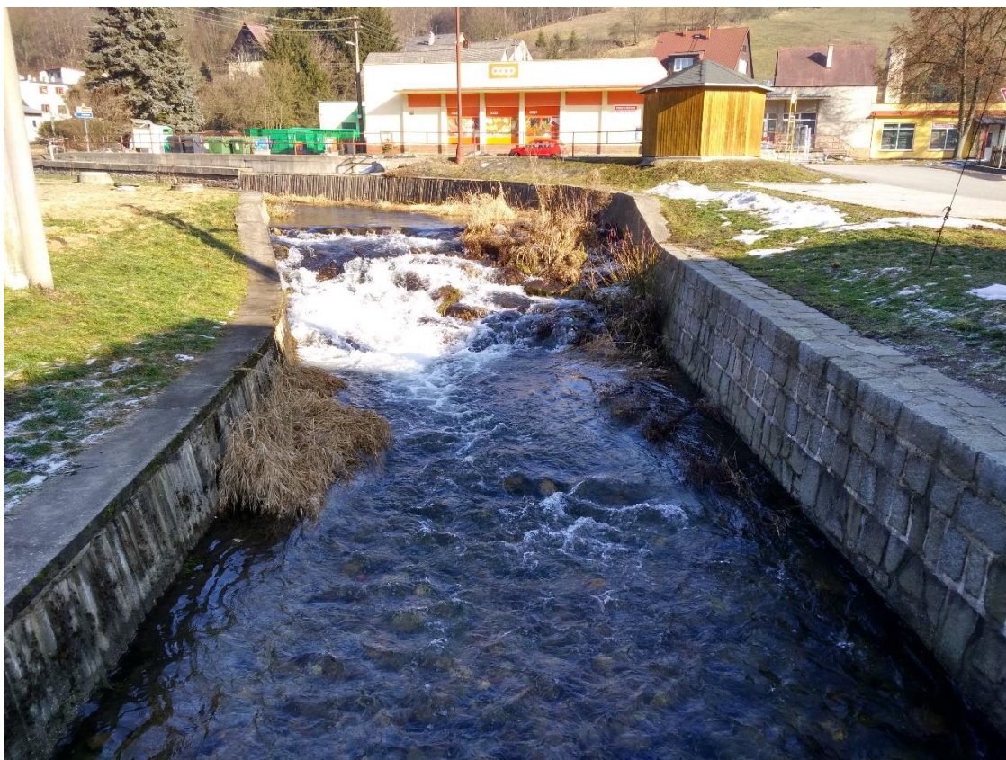
Příl. č. 22: Jez do výšky přibližně jednoho metru připomíná jen říční práh (Oskava, 2019)
