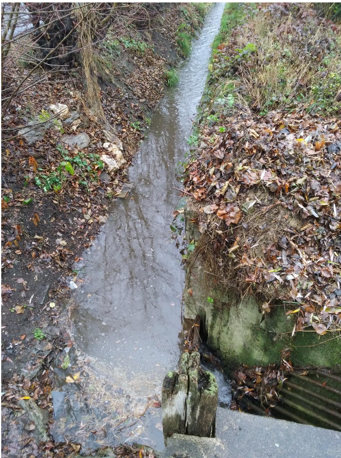
Příl. č. 31: Aktuální podoba náhonu na okraji pozemku objektu č.p. 10 (Dolní Libina, 2019)
