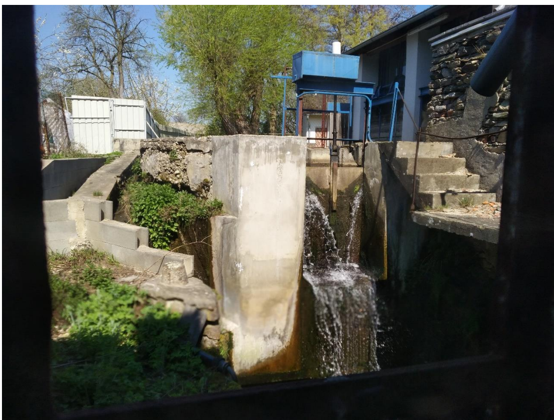
Příl. č. 34: Přepad a hlavní stavidlo náhonu je po letech služby v horším technickém stavu (Nová Hradečná, 2019)
