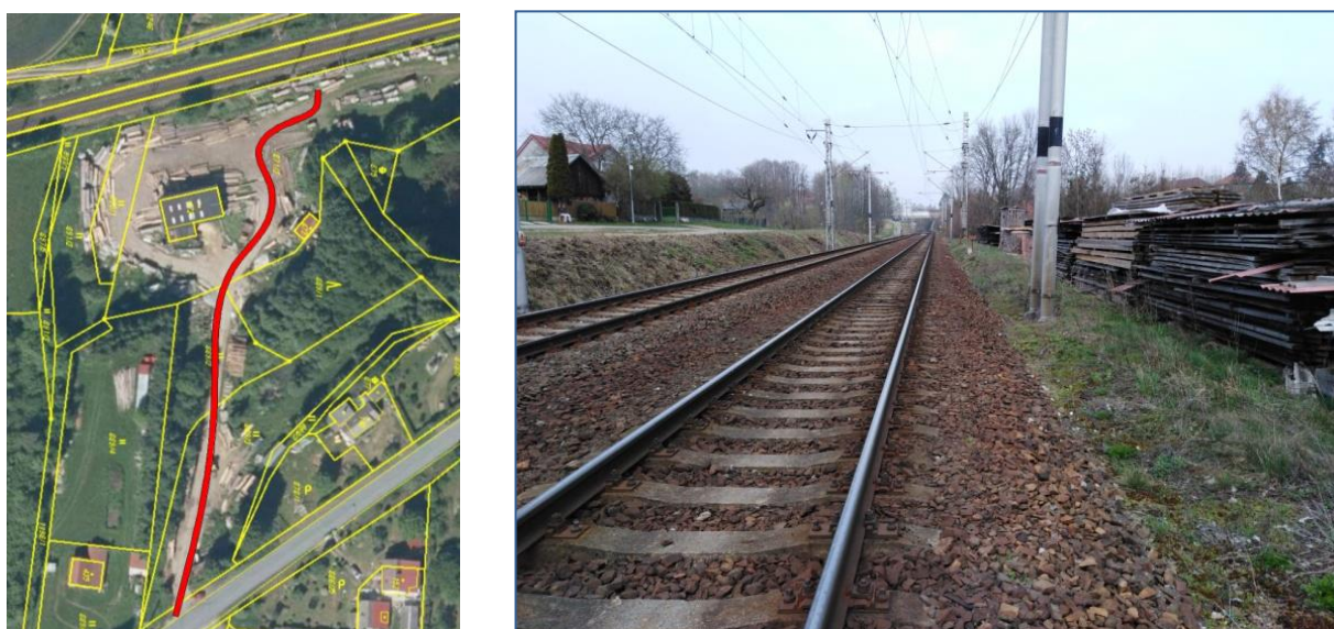
Obrázek 13 - Přístupová cesta km 300,569 [5]
