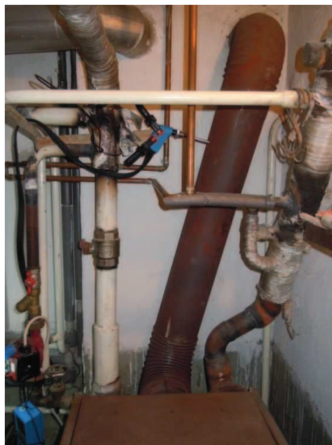
Obr. 3 – Zapojení měřicí soustavy
