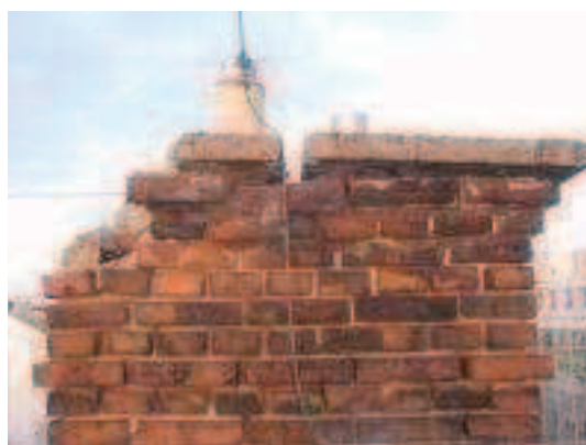
Obr. 23: Rozpadající se komín [26]
