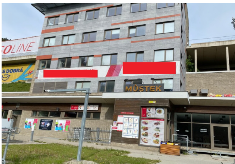
Obrázek 22: Reklama na správní budově 2
