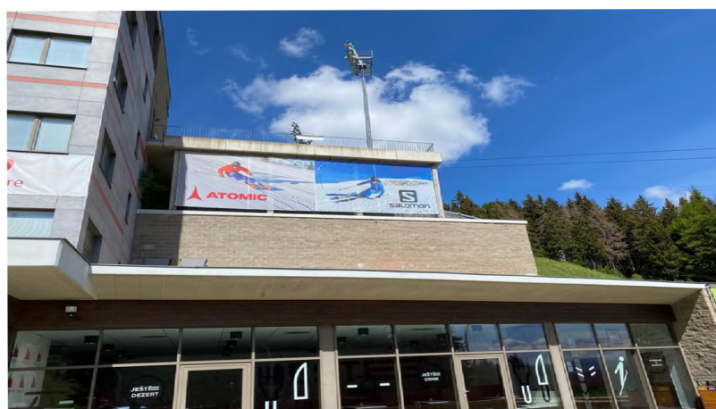
Obrázek 21: Reklama na správní budově 1
