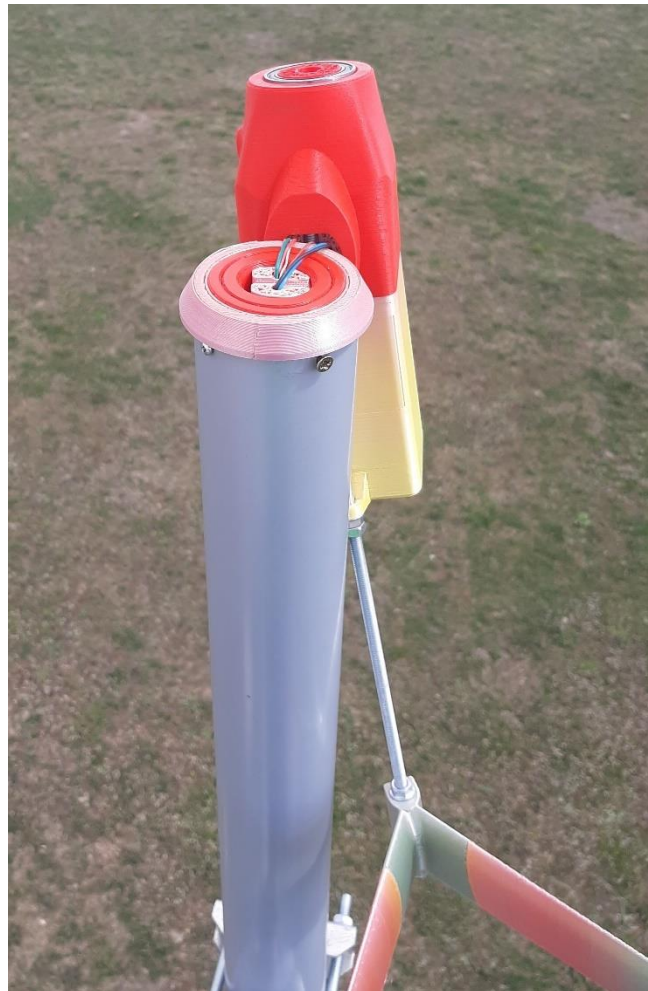
Obrázek 38 Přestřížení čepu PP_1009_01 a následná deformace větrné elektrárny
