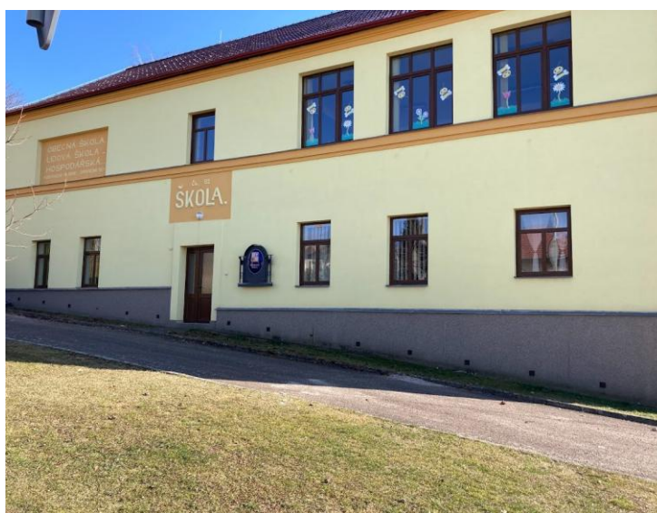
Obrázek 20 - Budova MŠ Petrovice (zdroj: Vlastní foto)
