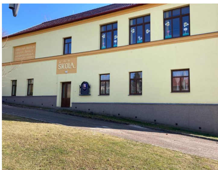
Obrázek 20 - Budova MŠ Petrovice (zdroj: Vlastní foto)
