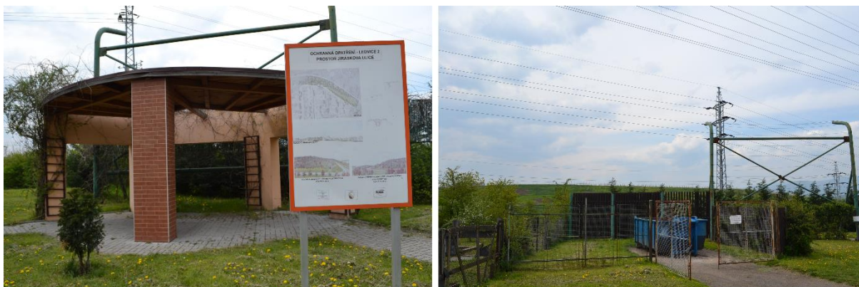
Obr. č. 48 Ledvický altán a konstrukce pro zelenou stěnu před ochranným valem (Foto: Adéla Kurešová)
