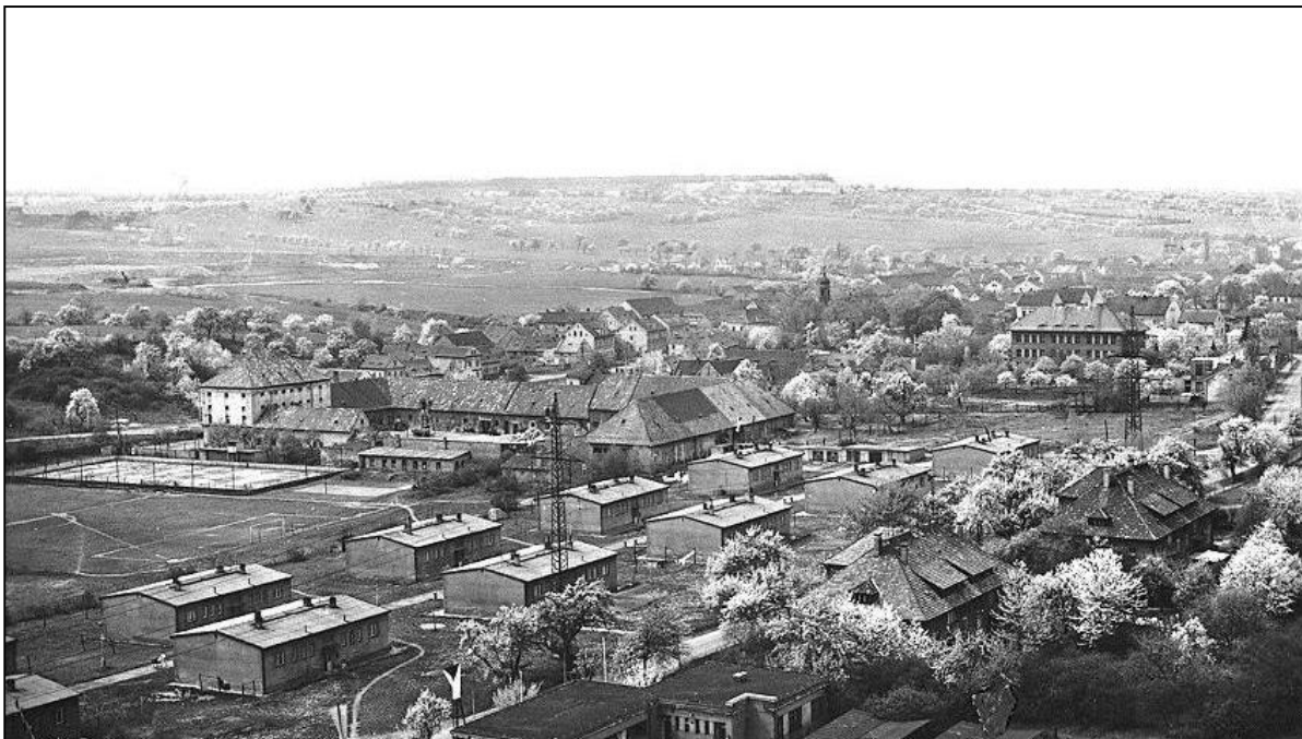
Obr. č. 34 Celkový pohled na obec směrem od šachty (ZANIKLÉ OBCE 2016)
