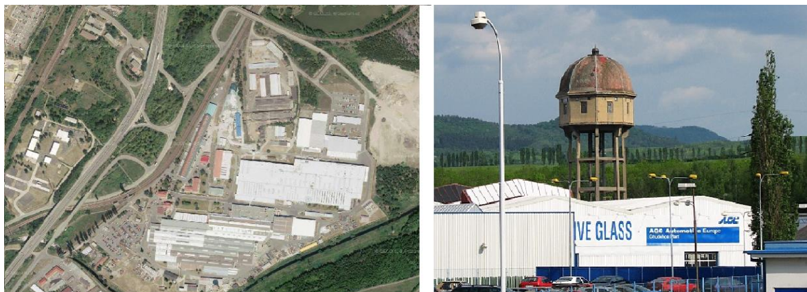
Obr. č. 25 Současný stav Chudeřic – letecký snímek a zachovalý vodojem (VODÁRENSKÉ VĚŽE 2016)
