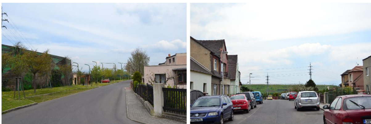
Obr. č. 49 Ochranná stěna s konstrukcemi pro zelenou stěnu + pohled z ulice na val (Foto: Adéla Kurešová)
