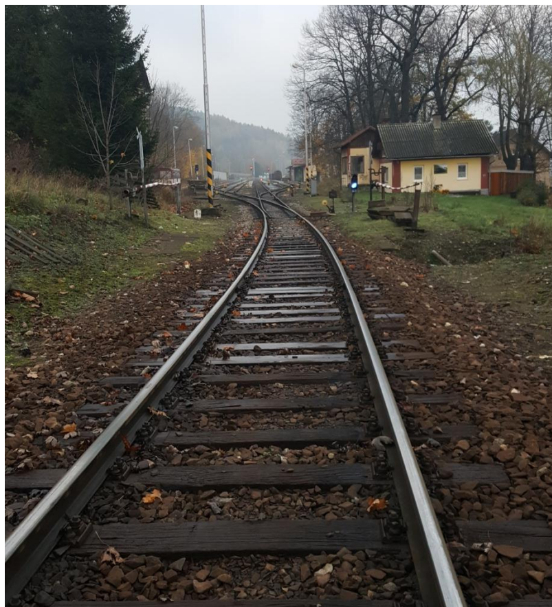
Obr. 2 – Pohled na přejezd P4292 a hornolipovské zhlaví
