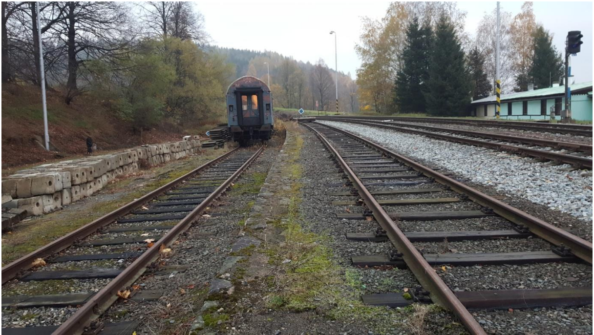
Obr.9 pohled na vlečkovou kolej a kolej 6d
