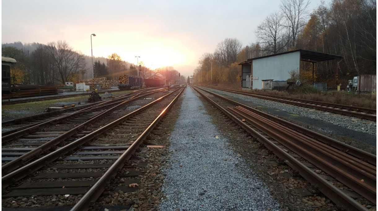
Obr. 7 pohled na žst. Lipová lázně od vápeneského zhlaví
