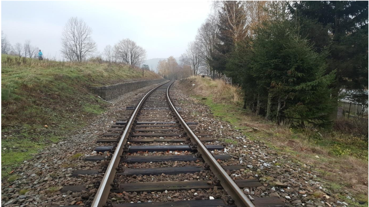
Obr. 1 Pohled na stávající gabionovou zídku směrem k žst. Lipová lázně
