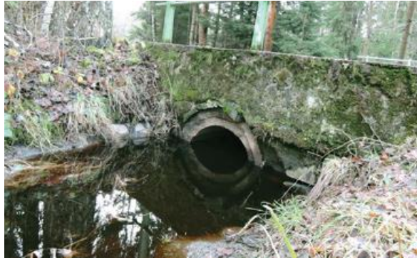
Obrázek č. 29: Propustky plné vody či bahna nemohou sloužit jako bezpečný průchod pro vydry ani jiná zvířata (Poledníková et al. 2017a)
