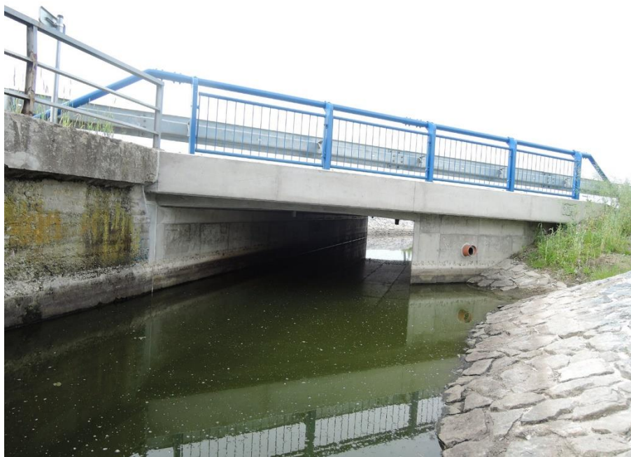
Obrázek č. 26: Absence břehů a voda od opěry k opěře jsou pro vydru častým problémem k podejití mostu (Poledníková et al. 2017b)
