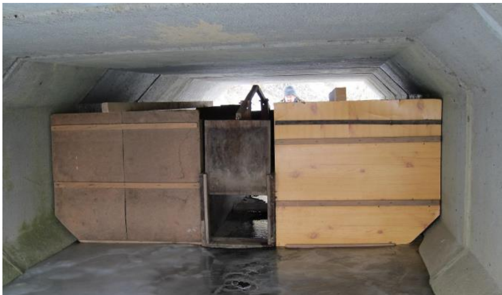
Obrázek č. 21: Mostní nášlapná past na vydry (Poledníková et al. 2018)
