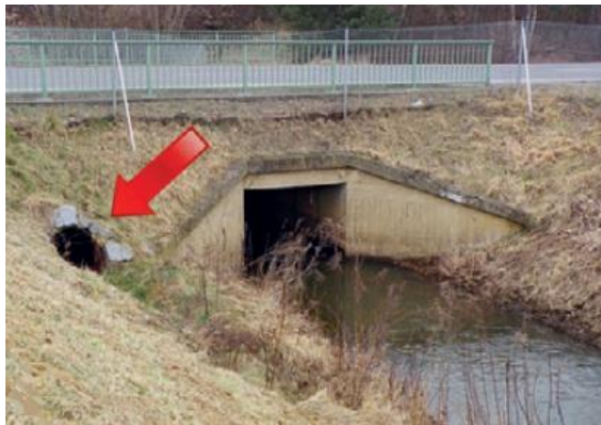
Obrázek č. 28: Zprůchodnění mostu výstavbou vydřího tunelu (červená šipka) (Hlaváč et al. 2017)
