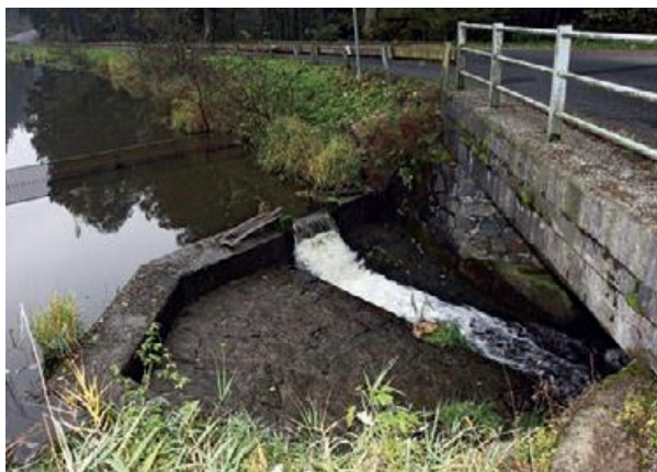
Obrázek č. 32: Bezpečnostní přepad s výškovým stupněm do 20 cm je pro vydru průchozí (Hlaváč et al. 2017)
