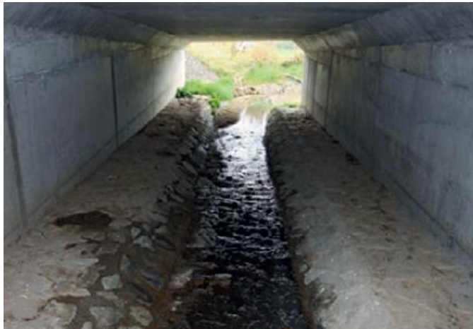
Obrázek č. 27: Vybudování berem v podmostí (Hlaváč et al. 2017)
