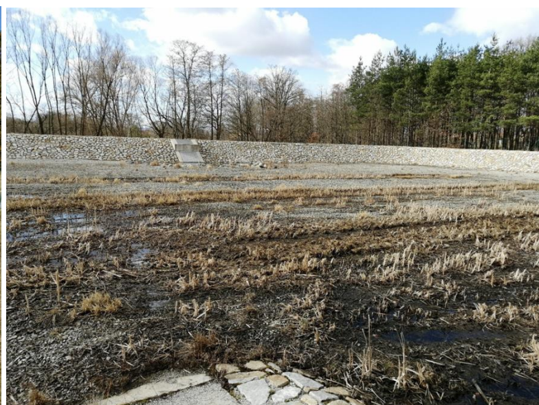
Obr. 12: RN Borek-Úsilné uvnitř nádrže
