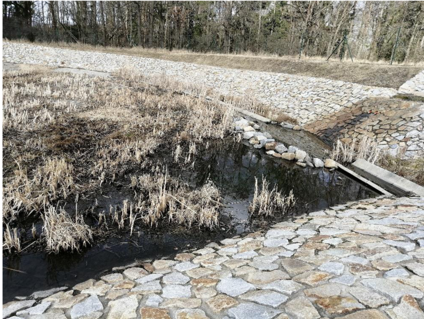
Obr. 16: Vegetace a stojatá voda v okolí přítoku do RN
