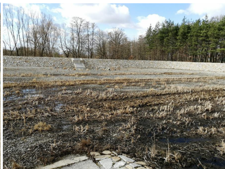
Obr. 12: RN Borek-Úsilné uvnitř nádrže
