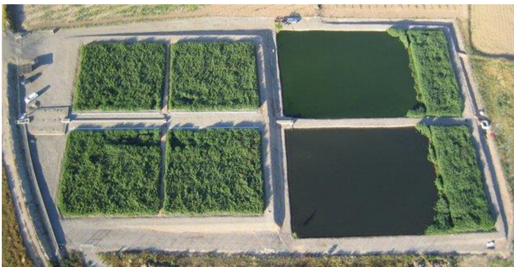
Obr. 3: Systém pro čištění odpadních vod sestávající ze tří usazovacích nádrží, čtyř mokřadů s horizontálním tokem a dvou mokřadů s vertikálním podpovrchovým tokem, (Samsó, 2014)
