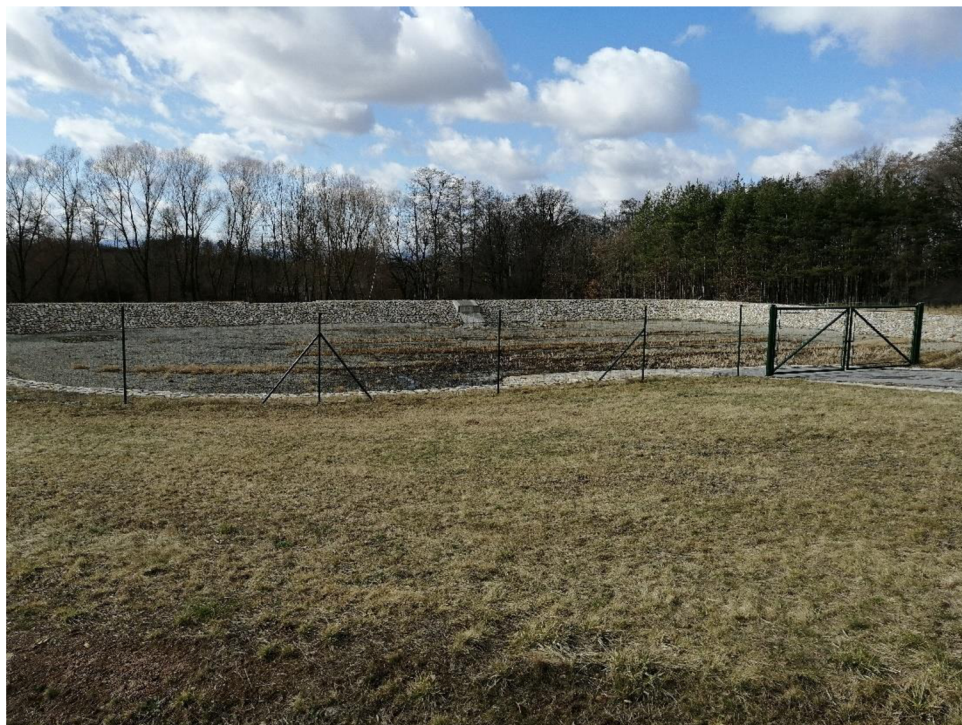
Obr. 2: Povrchová retenční nádrž Borek-Úsilné
