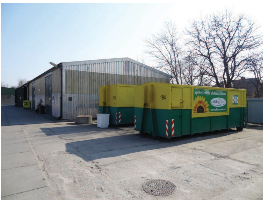
Příloha 9 – Skladovací hala sběrného dvora s kontejnery na zpětný odběr elektrozařízení [Foto autor]
