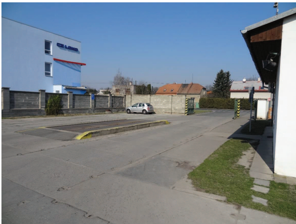
Příloha 7 – Mostová váha u vjezdu do sběrného dvora [Foto autor]
