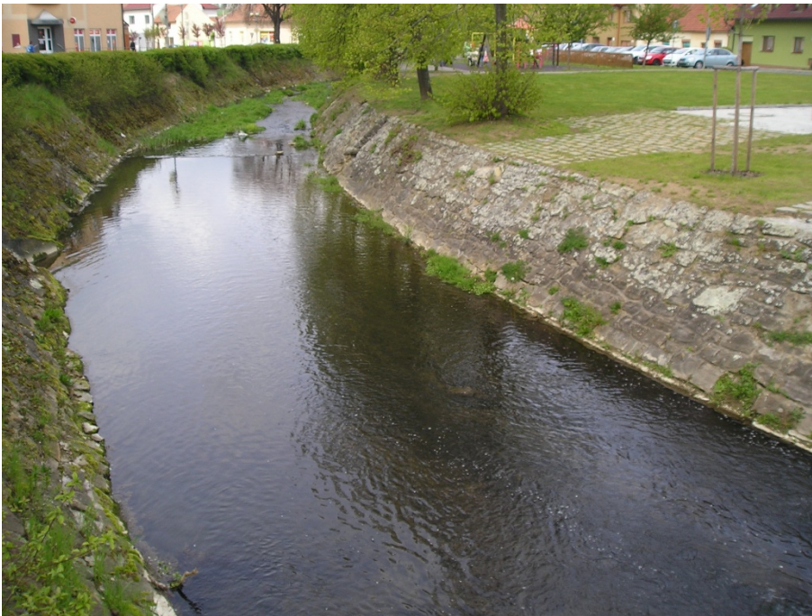
Obrázek č. 10 Zregulované a zrekonstruované koryto řeky v centru města Bojkovice (Naděžda Urbánková, 23.4.2016)
