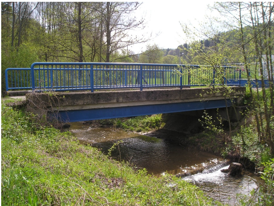
Obrázek č. 7 Silniční most nad obcí Pitín (Naděžda Urbánková, 23.4.2016)
