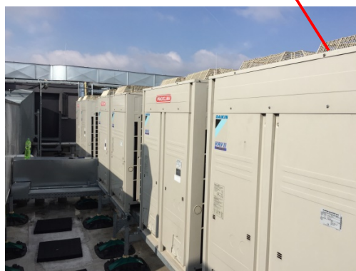
Obr. č. 30: Příklad instalace tepelného čerpadla (URL 25)
