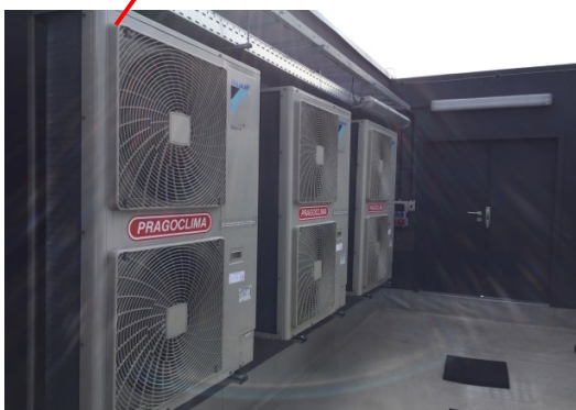
Obr. č. 29: Příklad instalace tepelného čerpadla (URL 25)
