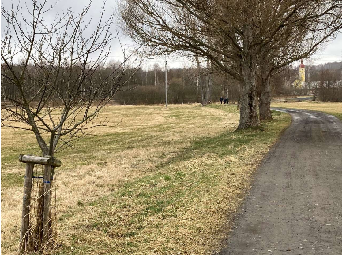
Obr. 37 – Zvýšení polní cesty za účelem řízeného rozlivu v obci Višňová
