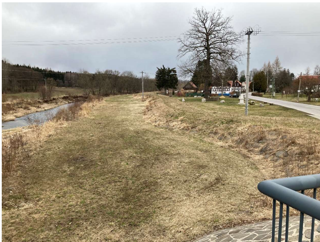
Obr. 40 – Ochranná hráz Víška na konci vesnice Víška
