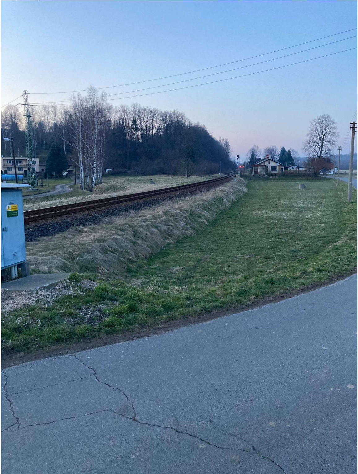
Obr 41. – Zvýšený drážní těleso Višňová
