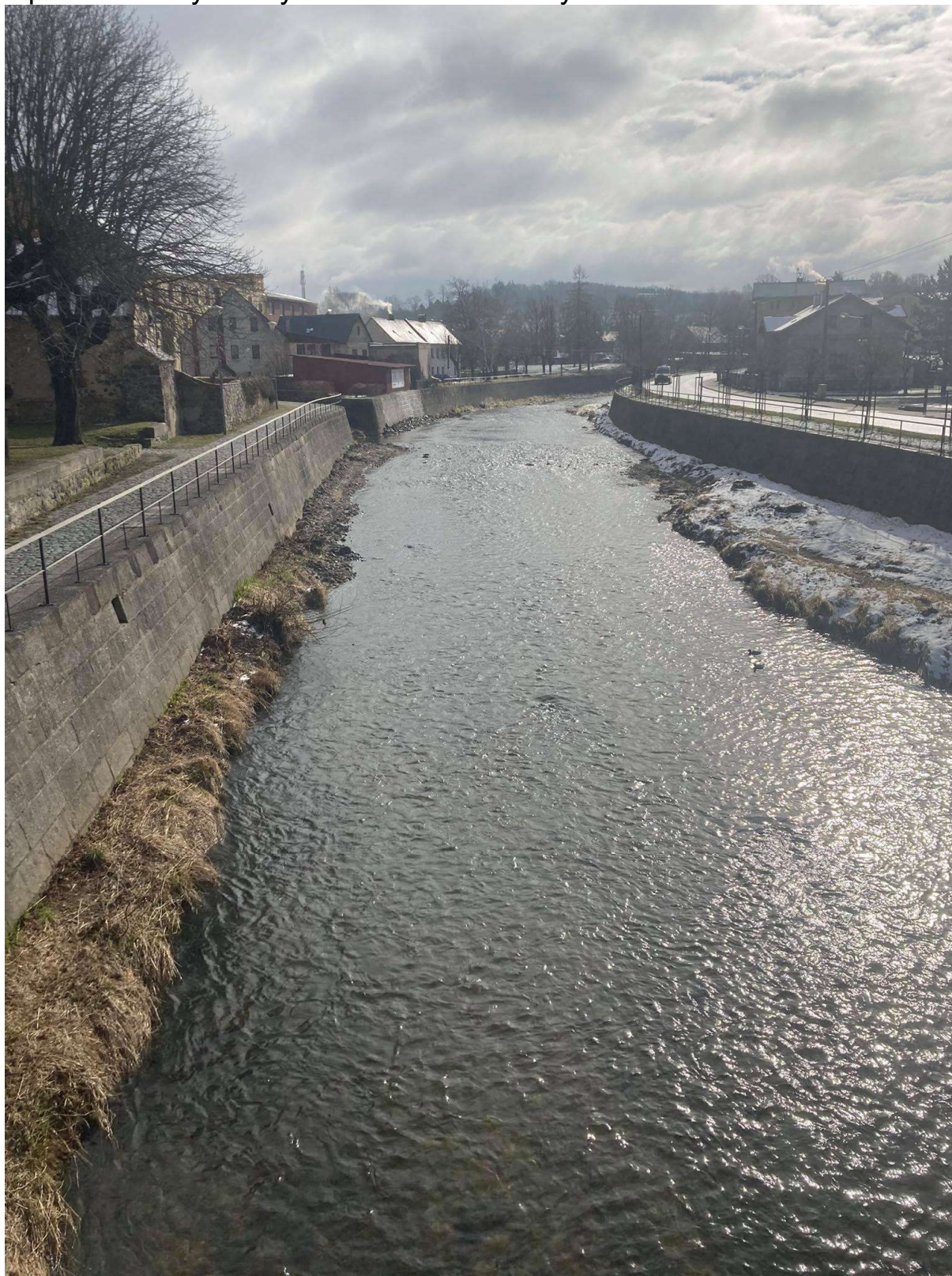
Obr. 42 – Opevněné koryto řeky Smědá ve městě Frýdlant
