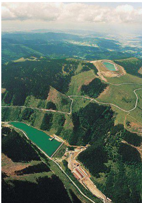
Obrázek 9: Přečerpávací vodní elektrárna Dlouhé Stráně. (KUDYZNUDY.CZ 2016)
