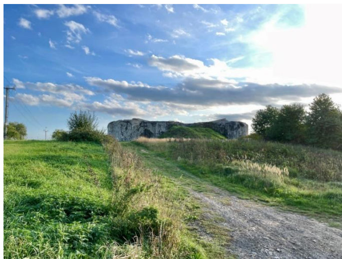
Obr. 11: Pěchotní srub MO-S 20 (foto: autor)
