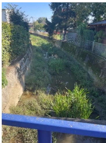
Obr. 26: Silně regulované koryto potoka (foto: autor)
