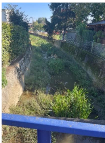
Obr. 26: Silně regulované koryto potoka (foto: autor)
