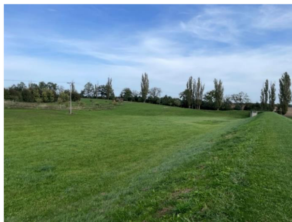
Obr. 14: Suchá retenční nádrž ve Vřesině (foto: autor)
