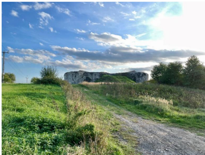
Obr. 11: Pěchotní srub MO-S 20 (foto: autor)
