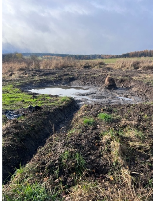
Obr. 24: Nově vybudovaná tůň
