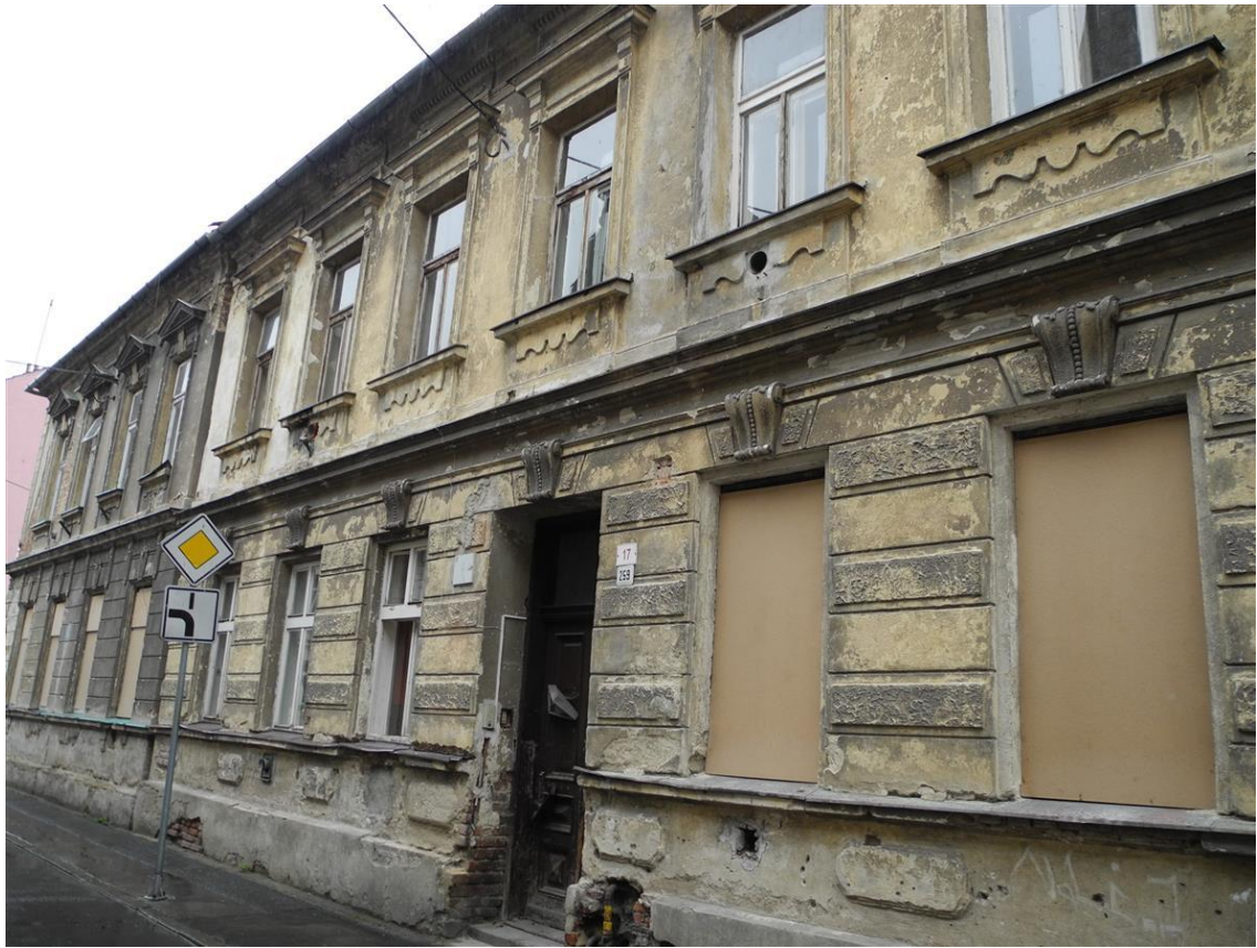
Obr. č. 4 – Stav před rekonstrukcí [14]
