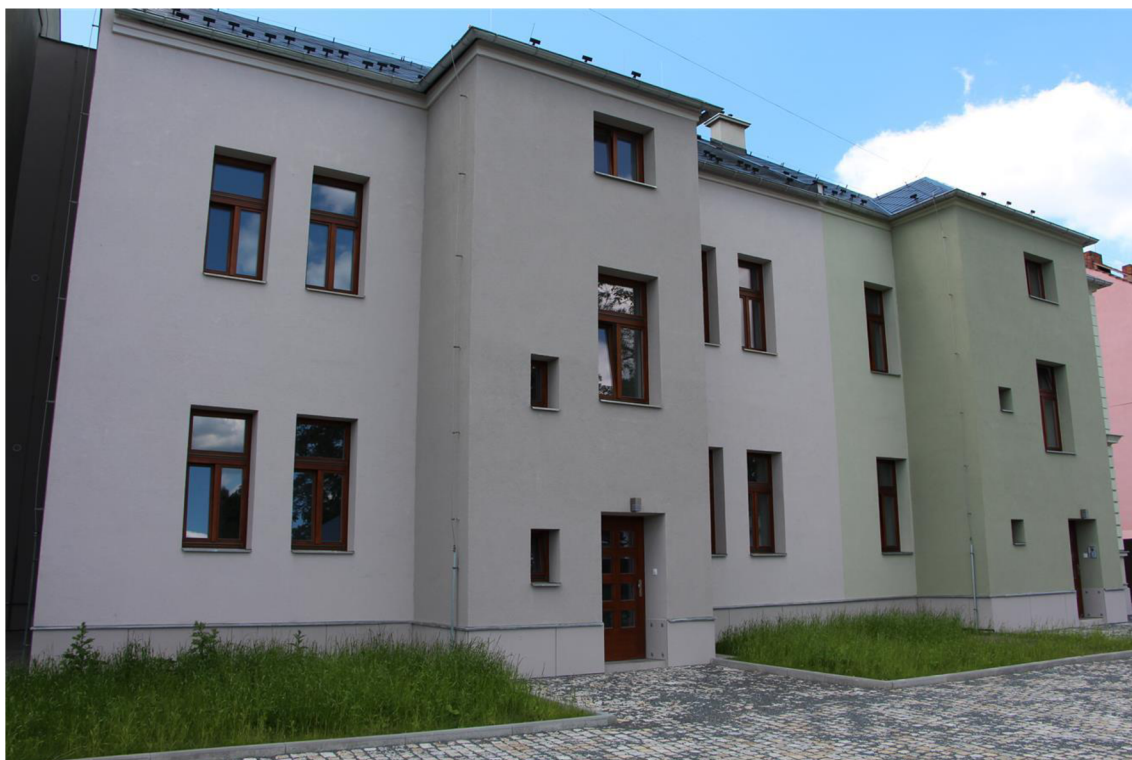
Obr. č. 7 – Stav po rekonstrukci, pohled na fasádu ze dvora [14]
