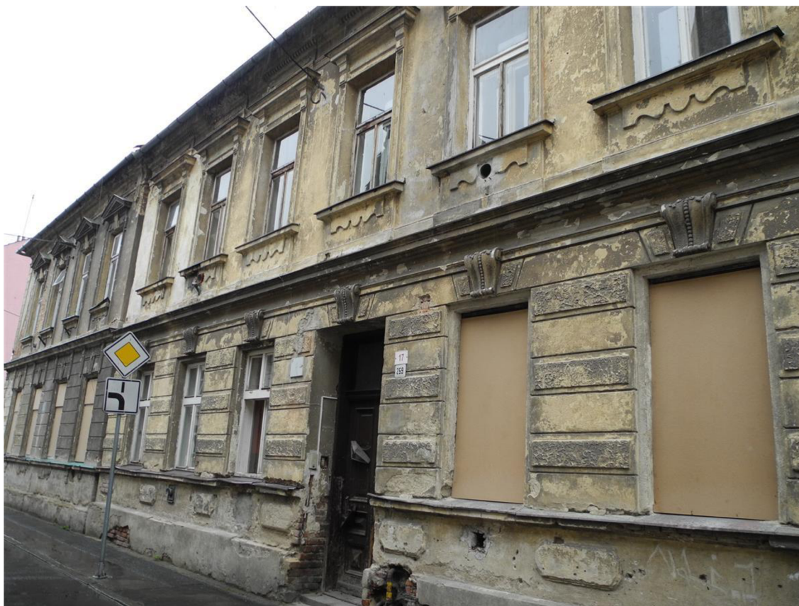
Obr. č. 4 – Stav před rekonstrukcí [14]
