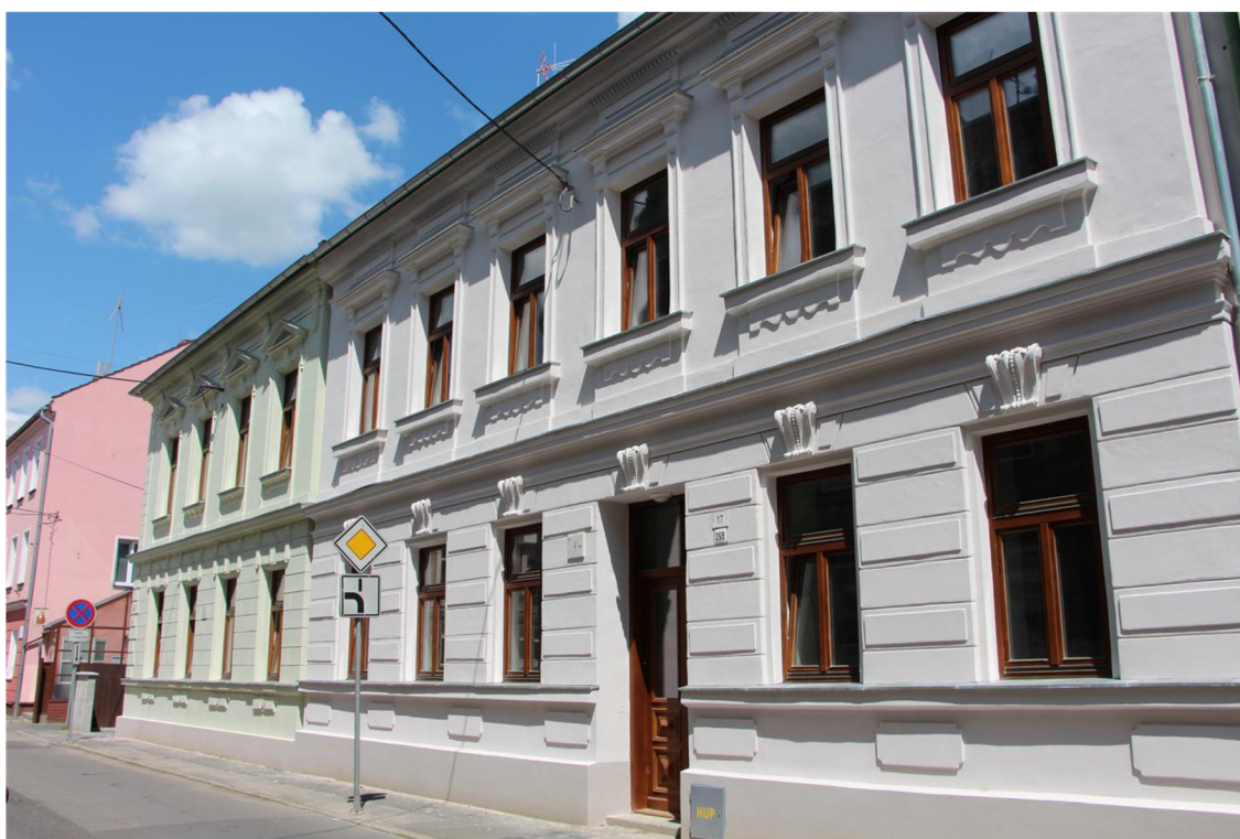
Obr. č. 6 – Stav po rekonstrukci, pohled na fasádu z ulice [14]
