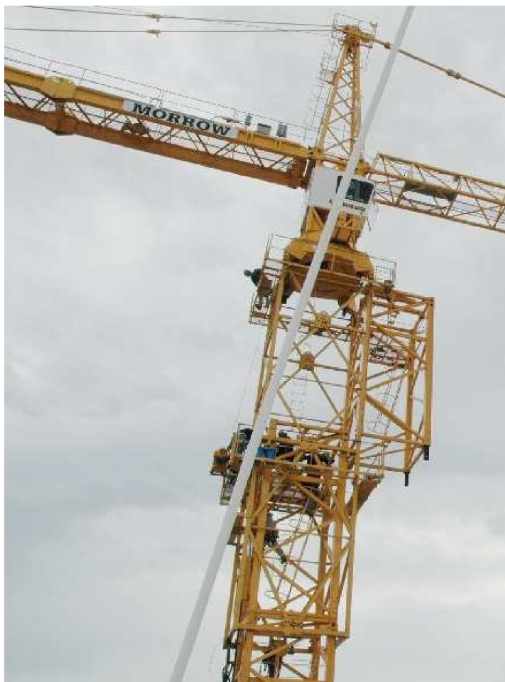
Obr. 6 Ukázka šplhacího zařízení u věžových otočných jeřábů [9]
