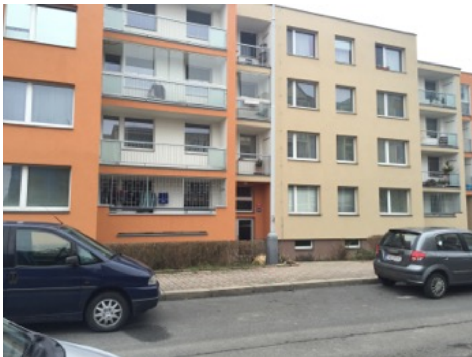
Obr. č. 3: Pohled západní - z ulice Proutěná po rekonstrukci
