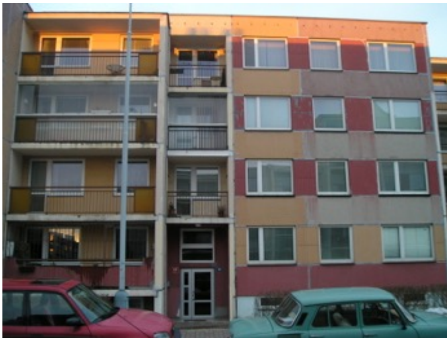
Obr. č. 2: Pohled západní - z ulice Proutěná před rekonstrukcí
