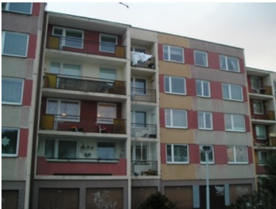
Obr. č. 4: Pohled východní před rekonstrukcí (Zdroj: SBD Kateřinky 875)
