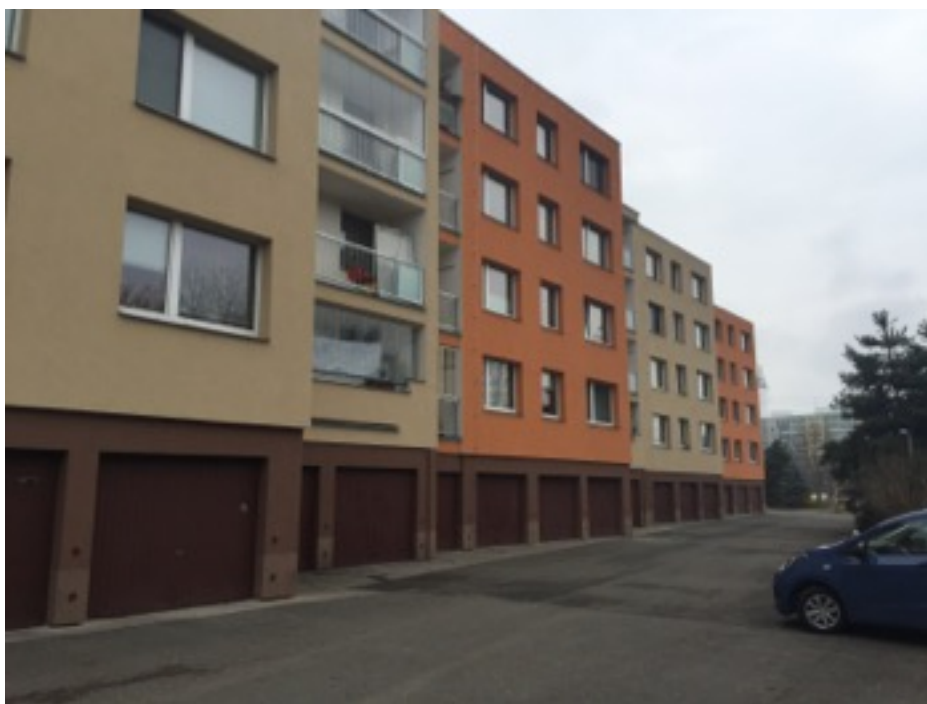
Obr. č. 5: Pohled východní po rekonstrukci (Zdroj: Vlastní zpracování)
