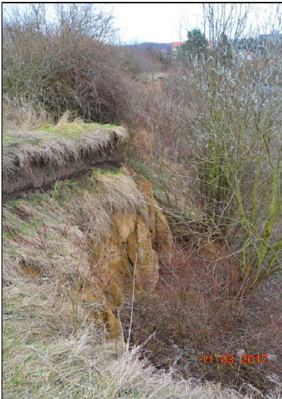
Obr. 6 - Prudký svah nad areálem cihelny, který vymílá voda z pole
