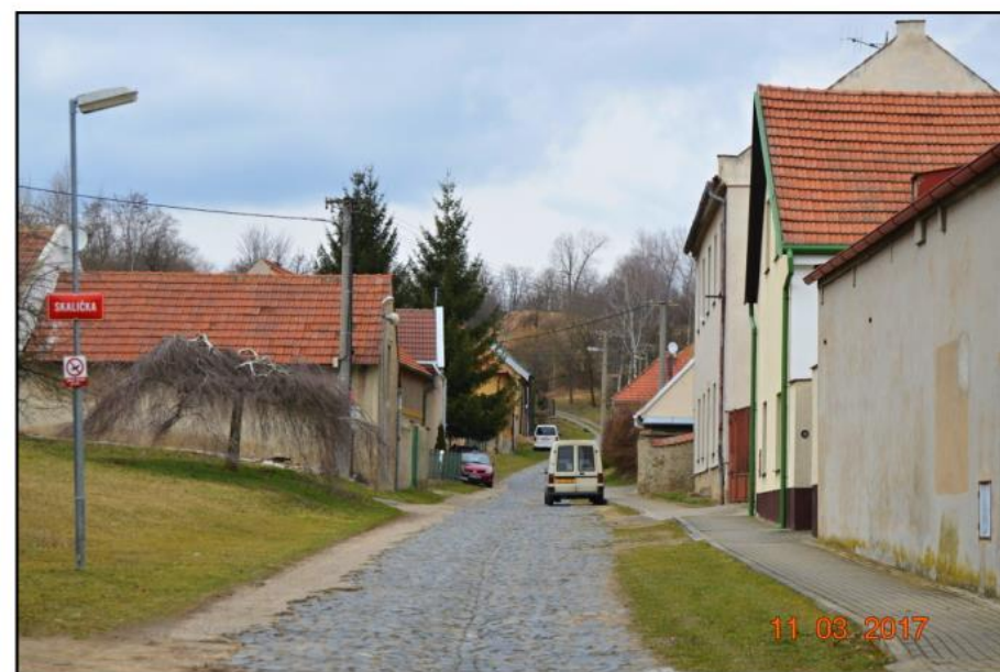
Obr. 4 - Ulice Skalička za obchodním domem (pohled severním směrem)
