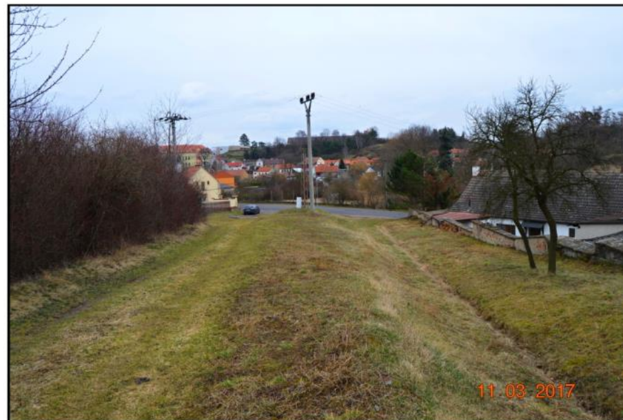
Obr. 5 - Strouha nad ulicí Hlavní odvádějící vodu z pole
