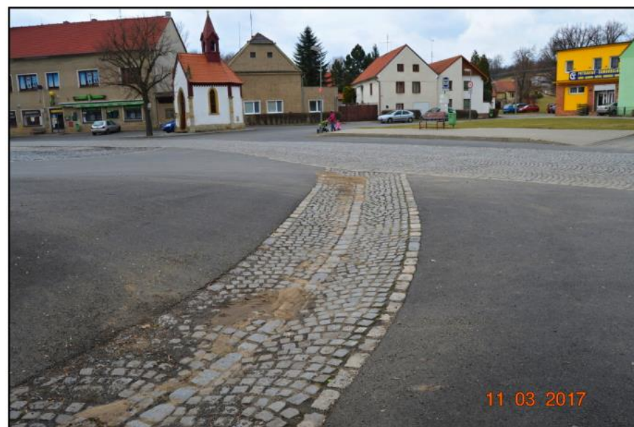
Obr. 5 - Dílčdný žlab přívádějící vodu ze Skaličky a Šafranic do potoka
