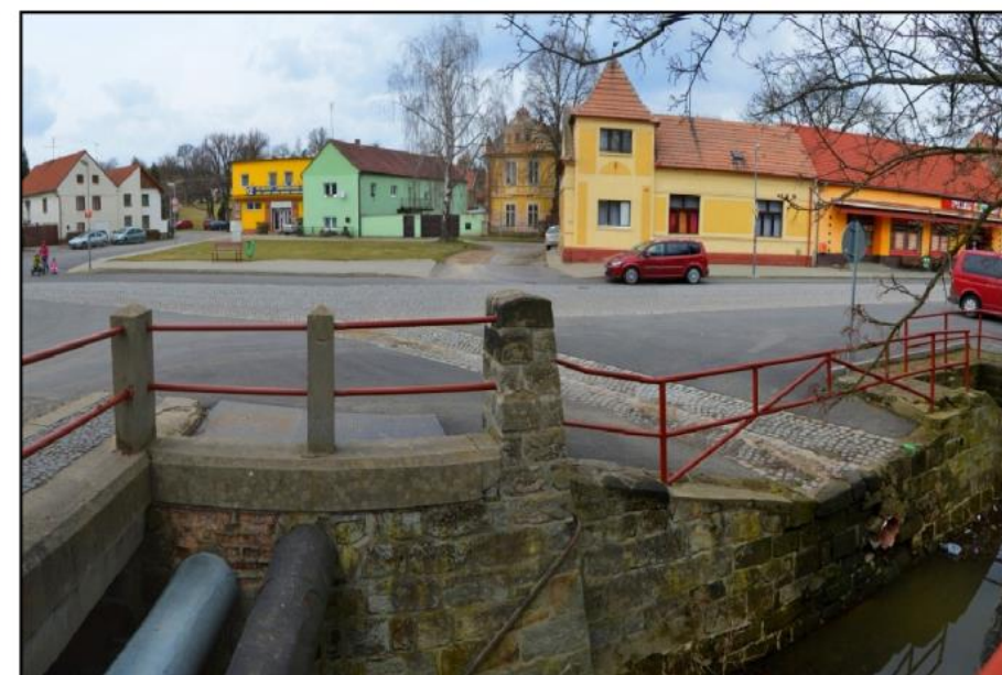
Obr. 6 - Zděné koryto Mšenského potoka v centru obce
