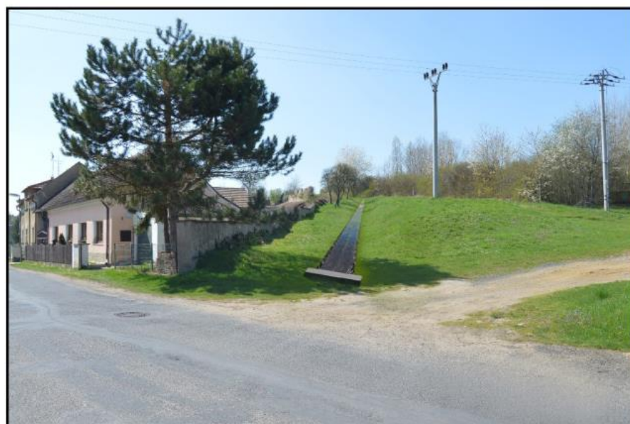
Obr. 9.22 - Zkapacitněný příkop kolem areálu bývalé cihelny ústící do propustku
