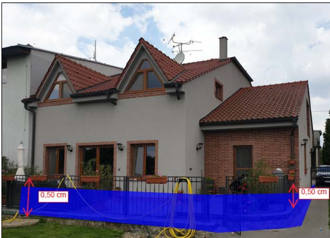
Obr. č. 7: Zasažená zadní část RD nad úroveň podlahy přízemí [vlastní]
