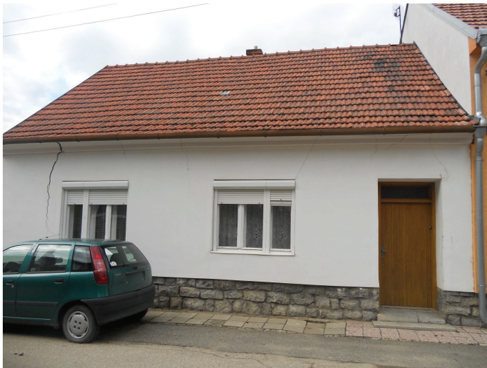
Obr. 5: Oceňovaný objekt – RD v obci Tvarožná – pohled z ulice.
