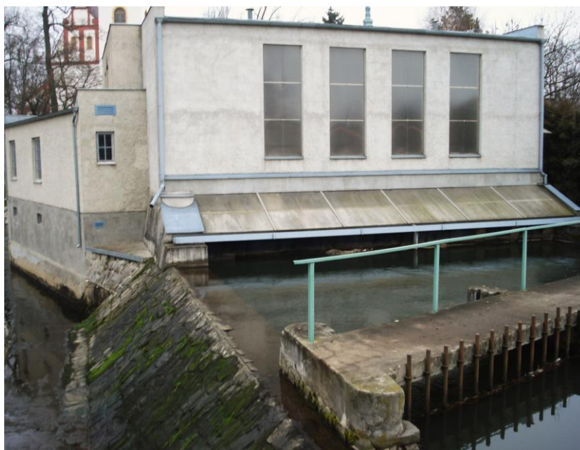
Obr. 2. Litovel aut. nádraží (1) – elektrárna
