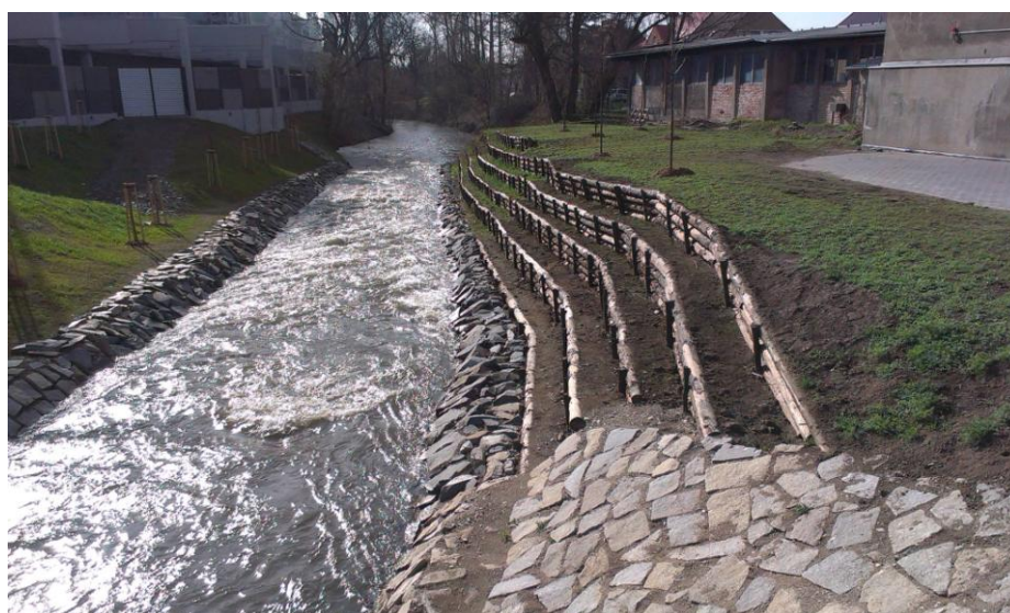
Obr. 10. Břehy zpevněné kameny a dřevem u Šantovky (Olomouc)
