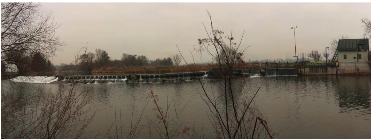
Obr. 17. Kožušany-Tážaly – 1. Jez se šikmou spádovou deskou, 2. Jez s kolmou spádovou deskou, 3. Jez s kolmou spádovou deskou, 4. elektrárna
