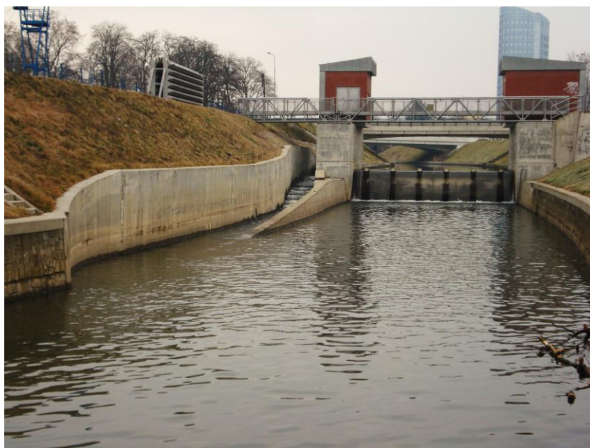
Obr. 13. Obtokový kanál s rybím přechodem
