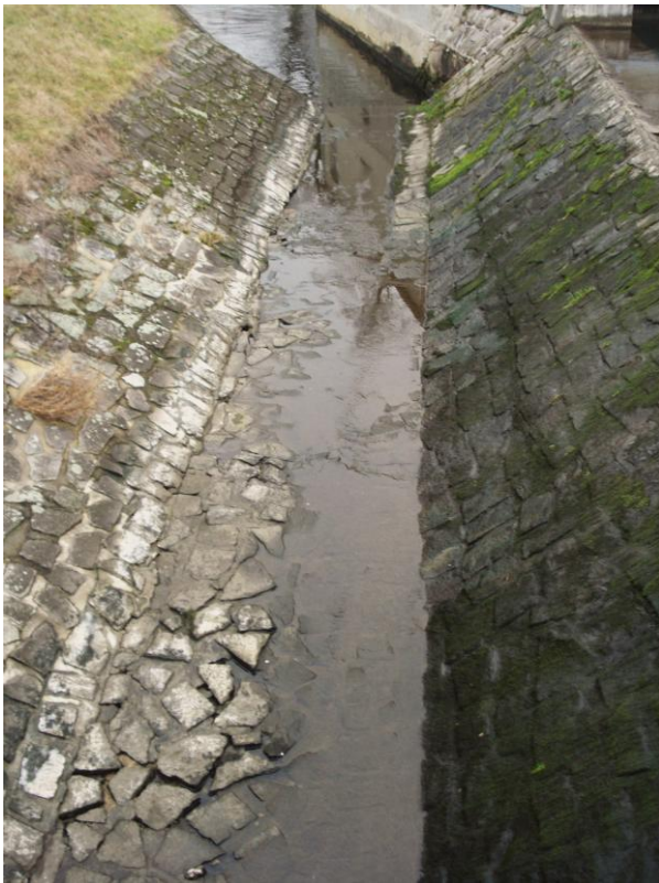
Obr. 3. Litovel aut. nádraží (odtokové koryto)
